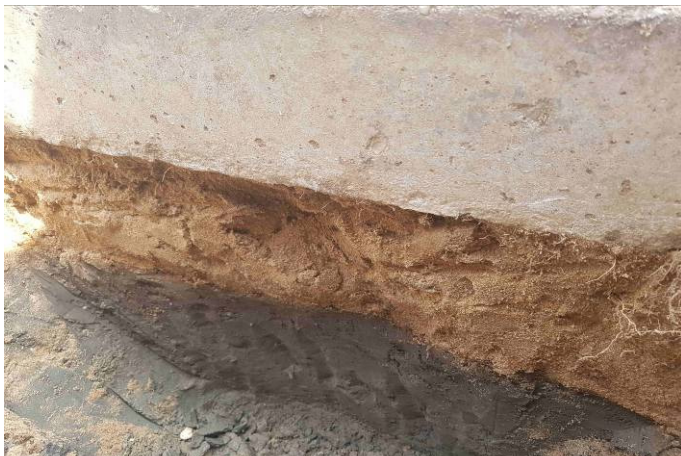
Foto 5: inspectiesleuf SL131 / bodemopbouw
