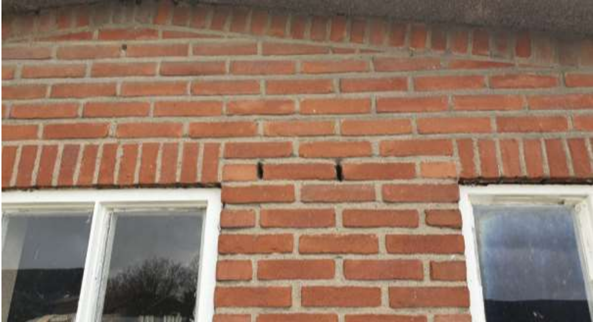
Figuur 8 Open stootvoegen
