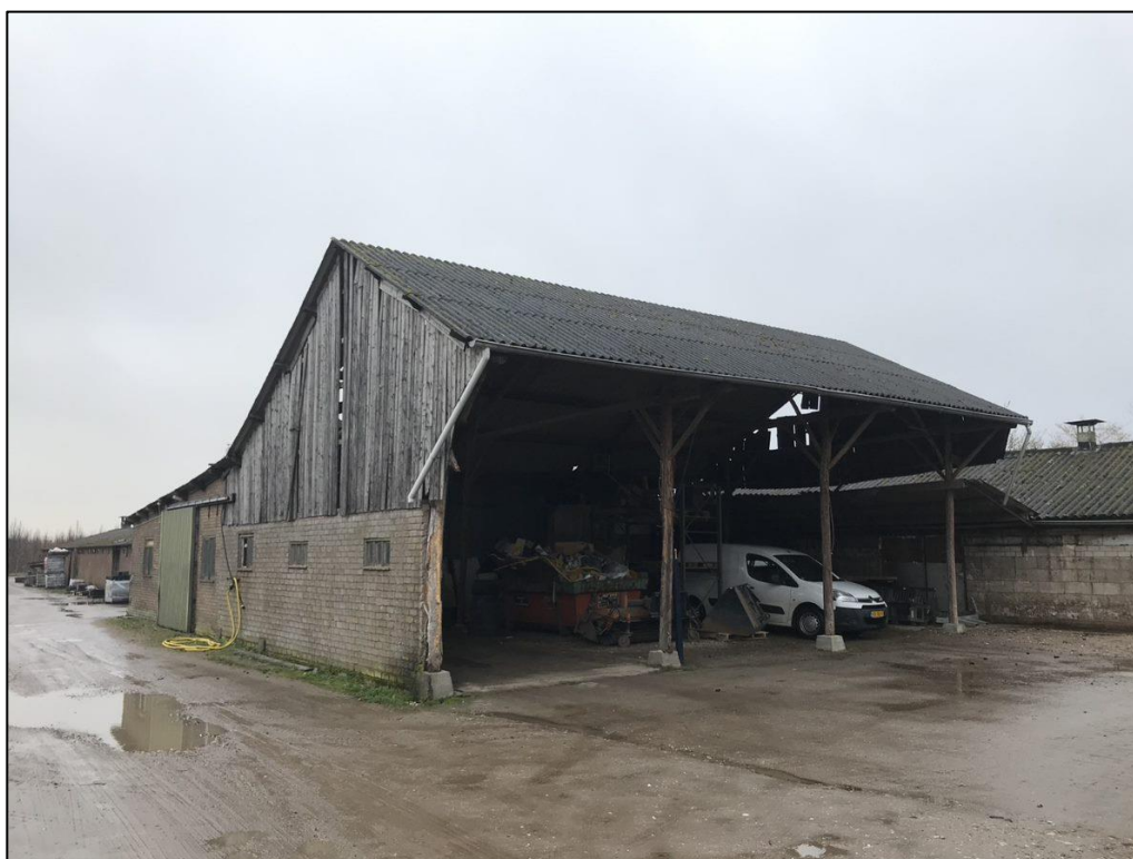
Figuur 2 Bijgebouw 4 op de planlocatie in Dodewaard. Dit bijgebouw wordt gesaneerd.
