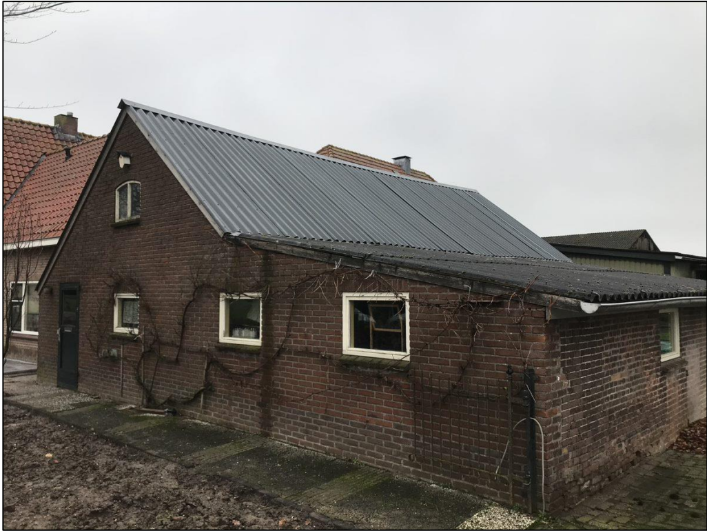
Figuur 5 Bijgebouw 2 op de planlocatie in Dodewaard. Dit bijgebouw wordt gesaneerd.
