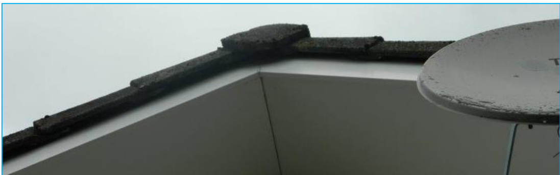
Foto: Openingen die toegang bieden tussen ruimte tussen dakpannen en beschot.
