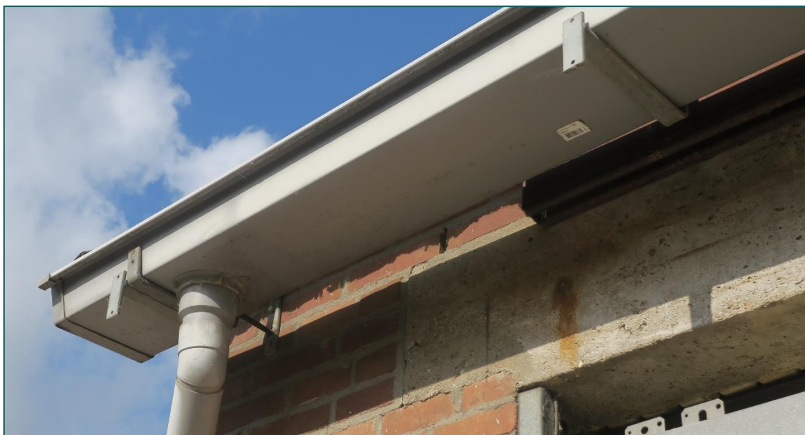
Figuur 3.1 Er bevinden zich twee stootvoegen aan de oostzijde van gebouw C, achter de dakgoot.
