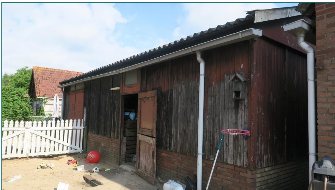
Figuur 1.4 Gebouw B bestaat uit een muur van deels baksteen en deels hout. Het dak bestaat uit een houten dakbeschot met daarboven een laag golfplaten.
