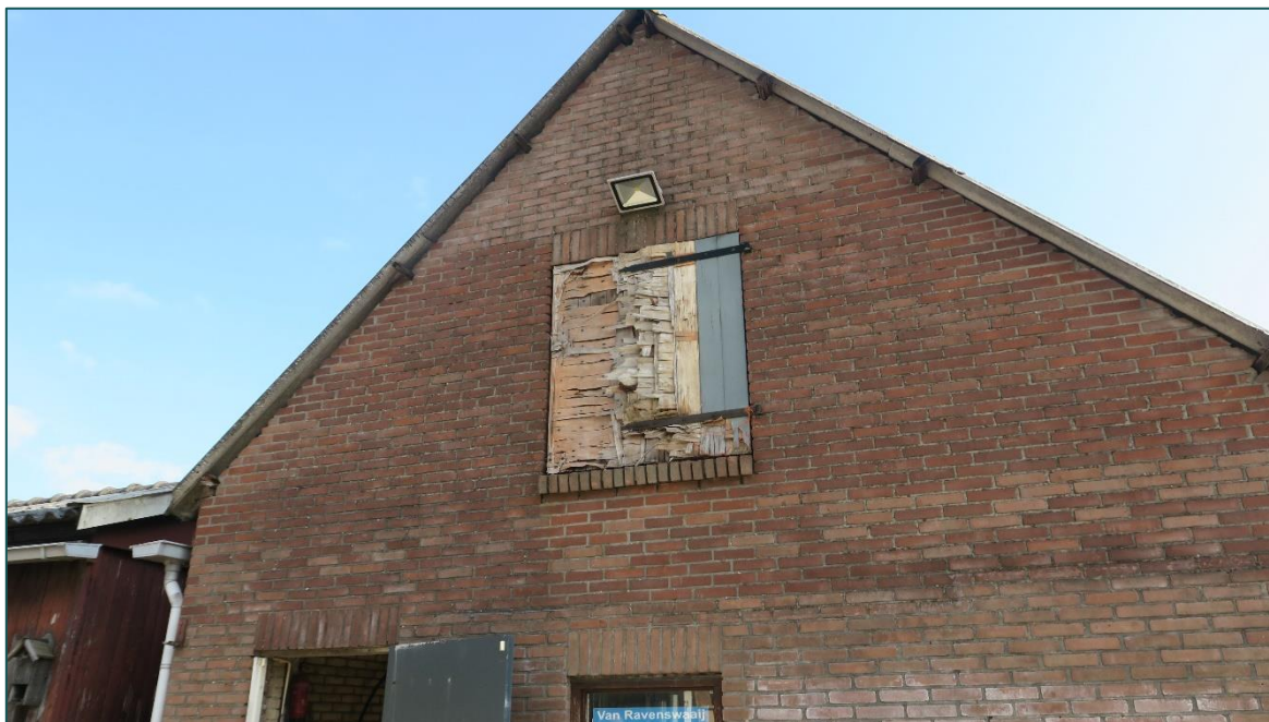
Figuur 1.6 Gebouw C bevat een dubbele bakstenen muur met luchtsponw en stootvoegen. Het dak bestaat uit een enkele laag golfplaten en houten balken.
