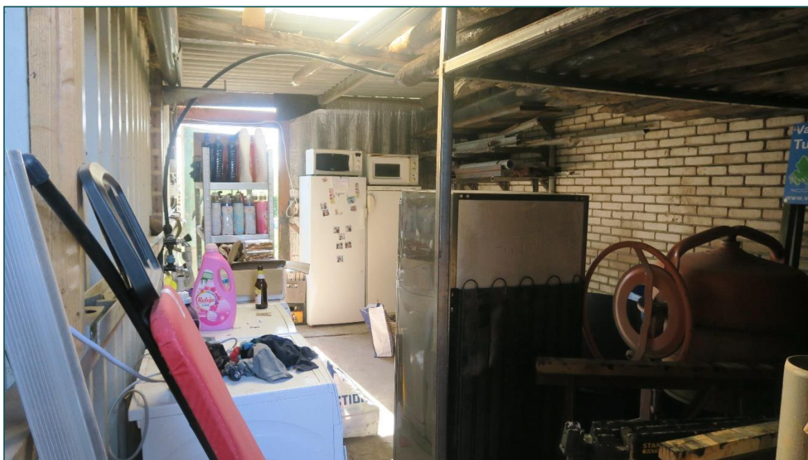
Figuur 1.7 Aan de noordzijde van gebouw C is een kleine ruimte aanwezig die bestaat uit een bakstenen muur van gebouw C en verder muren van golfplaten bevat. Daarnaast is een dak bestaande uit golfplaten aanwezig.
