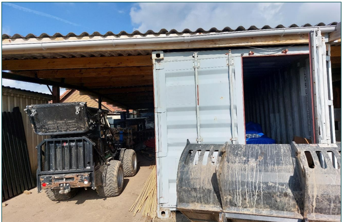
Figuur 1.3 Gebouw A bestaat uit twee zeecontainers met erboven een dak van houten balken en golfplaten.
