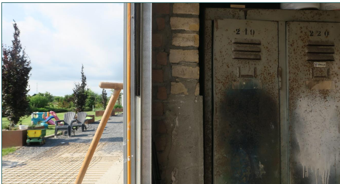
Figuur 3.2 Vanuit de opening van de garagedeur is te zien dat de bakstenen muren van gebouw C op elkaar aansluiten.
