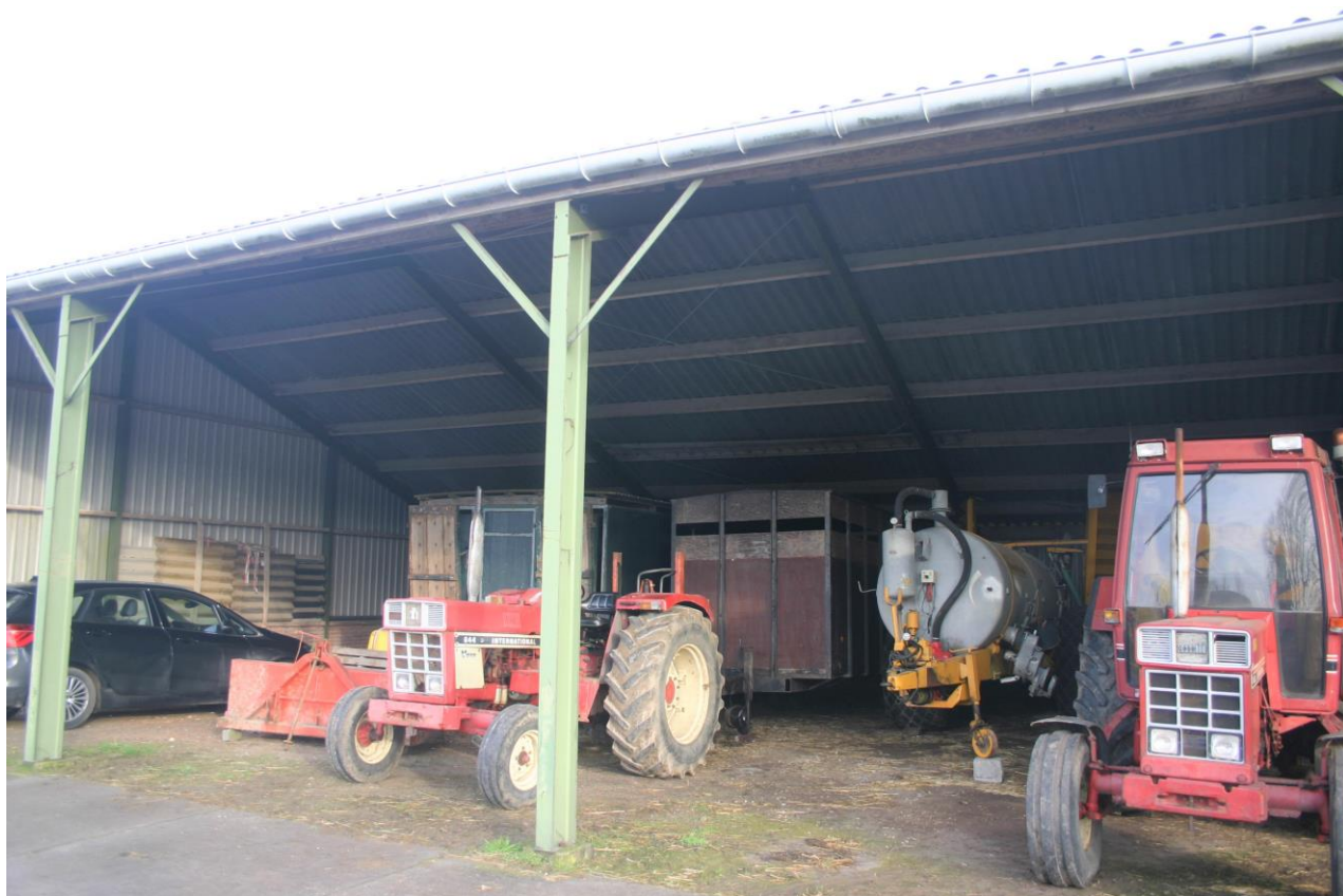
Figuur 4.4.5. De kapschuur.
