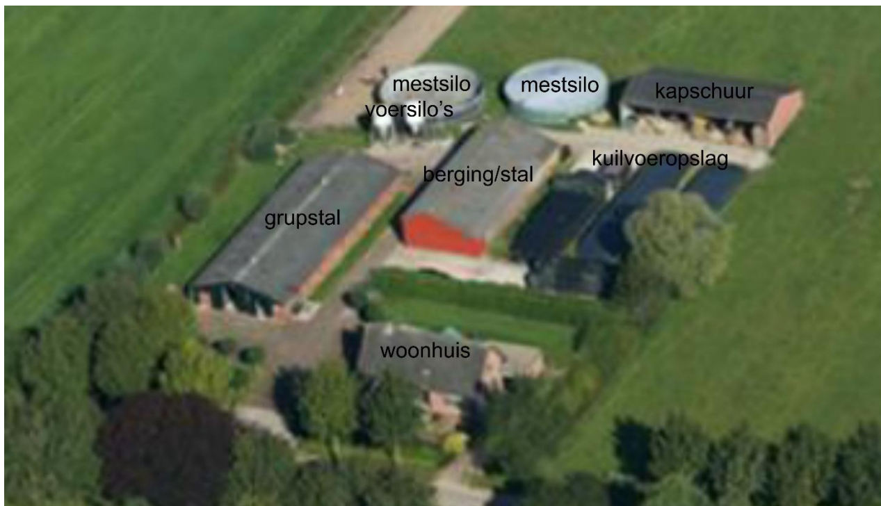
Afbeelding 3: op de locatie aanwezige bebouwing (bron: google earth)
