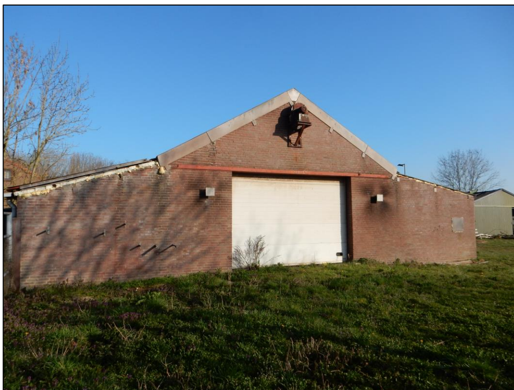
Figuur 2 Eén van de te saneren schuren (schuur 1).
