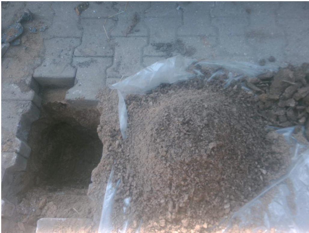
Foto 4: asbestinspectiegat 4a
