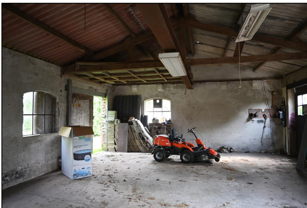
Figuur 2 Binnenkant van de aanwezige schuur.
