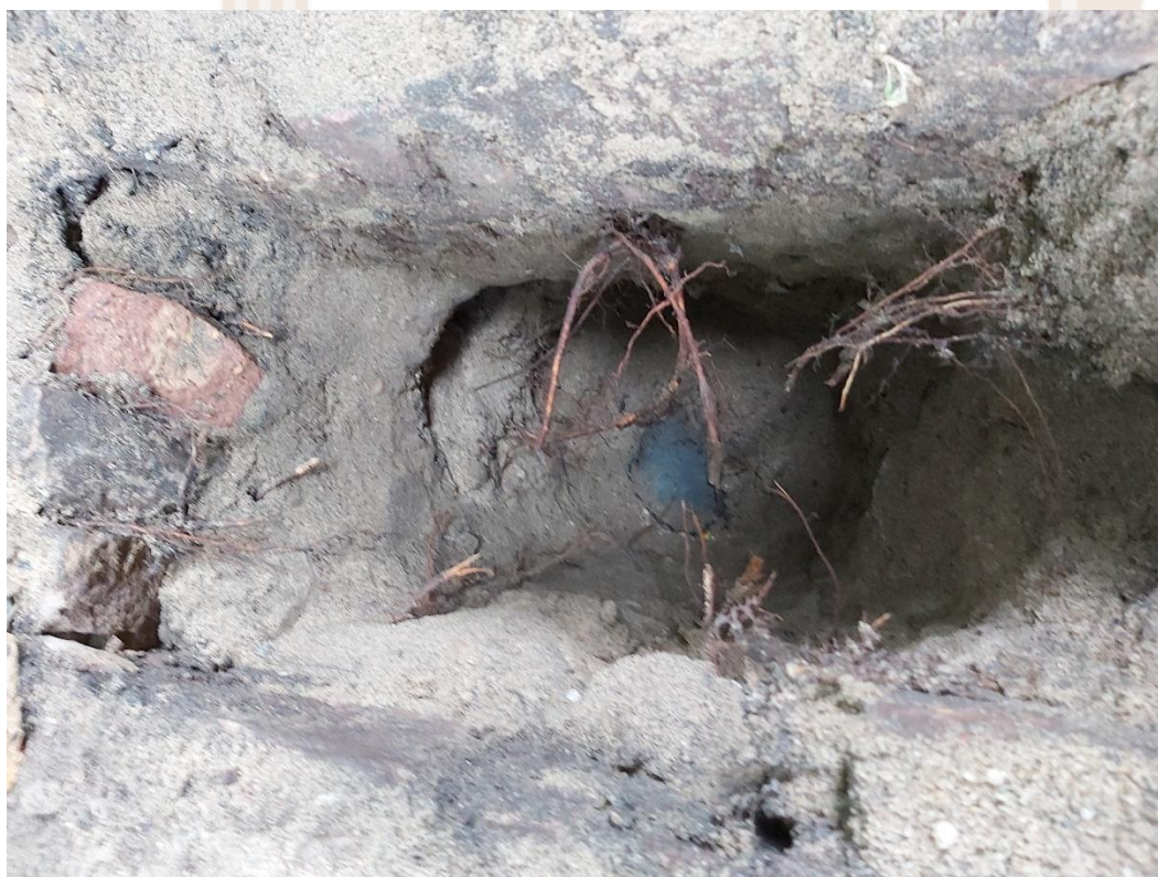
Figuur 2 Aangetroffen PVC leiding met omhulsel
