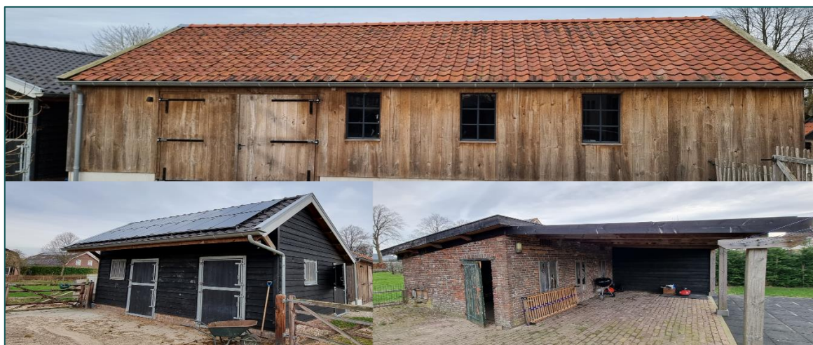
Figuur 1.3 Op de planlocatie is men voornemens om de volgende gebouwen te slopen: een grote schuur, twee paardenstallen en een vervallen schuur.
