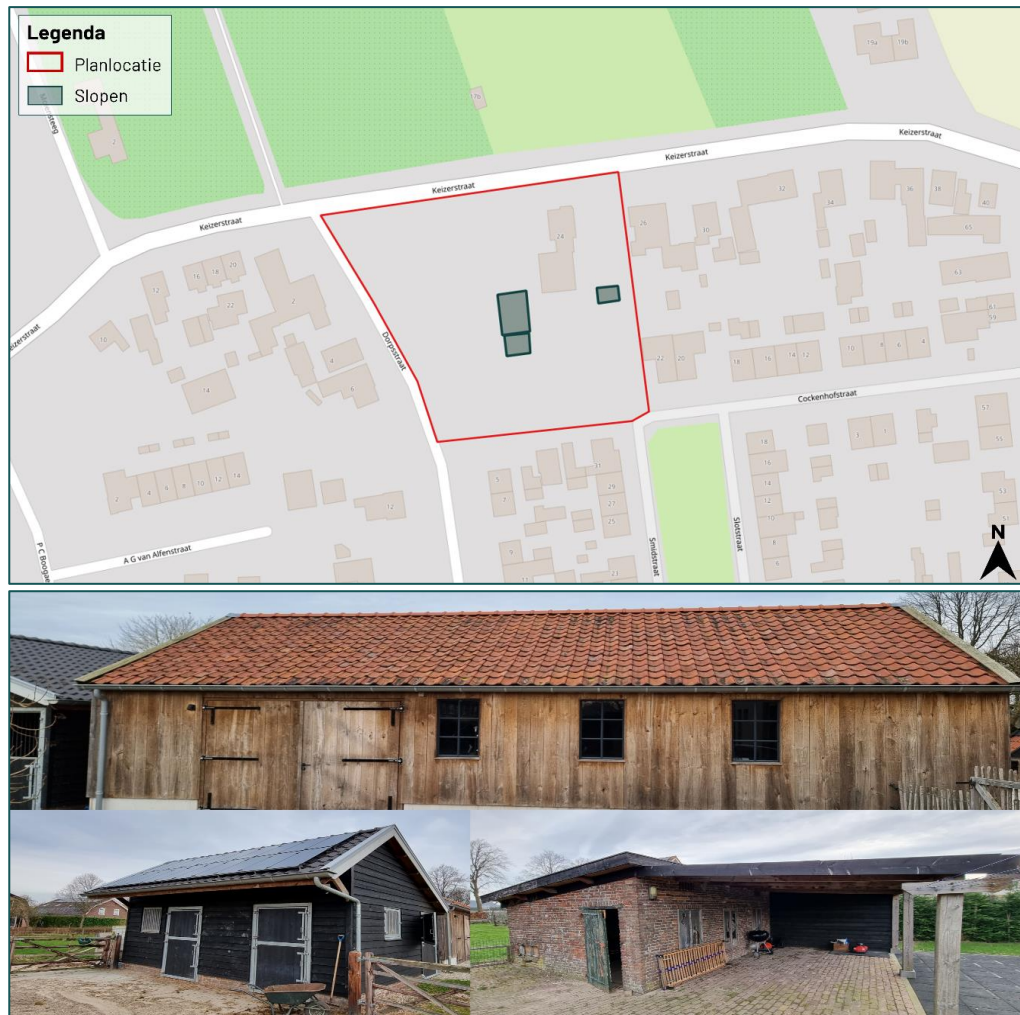
Figuur 1 De planlocatie (boven) en te slopen schuren (onder) (Bron: Pickert, 2022).
