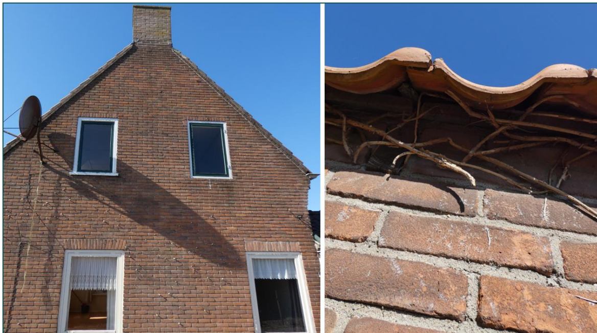
Figuur 3.1 Links: in de gevels van de woning zijn geen openingen aangetroffen. Rechts: openingen onder dakpannen van het schuurtje zijn geblokkeerd door klimplanten of omliggende bebouwing en struiken.
