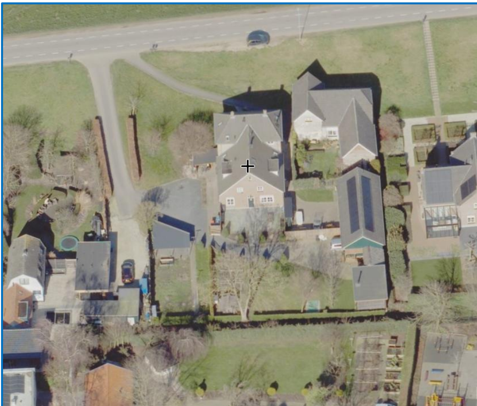
Afbeelding, bouwlocatie Rijnbandijk 33 (Bron: Street Smart) ([01 MAART 2023])
