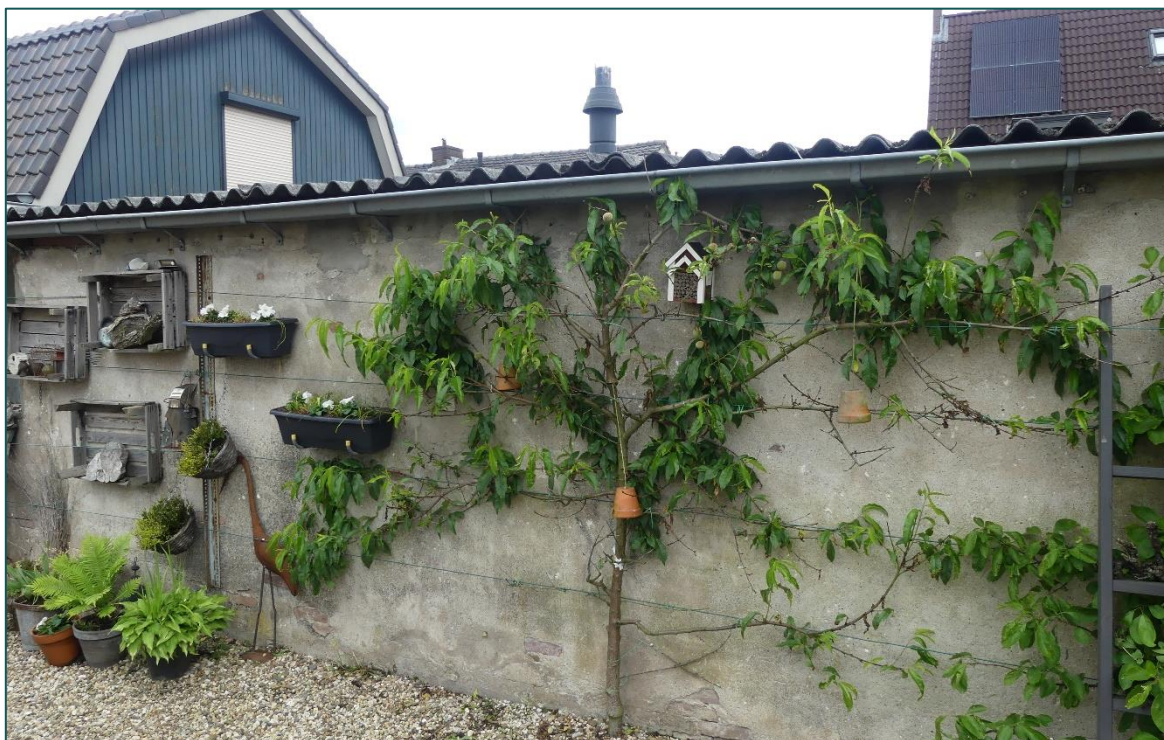
Figuur 2 Westzijde van het te slopen horecagebouw.
