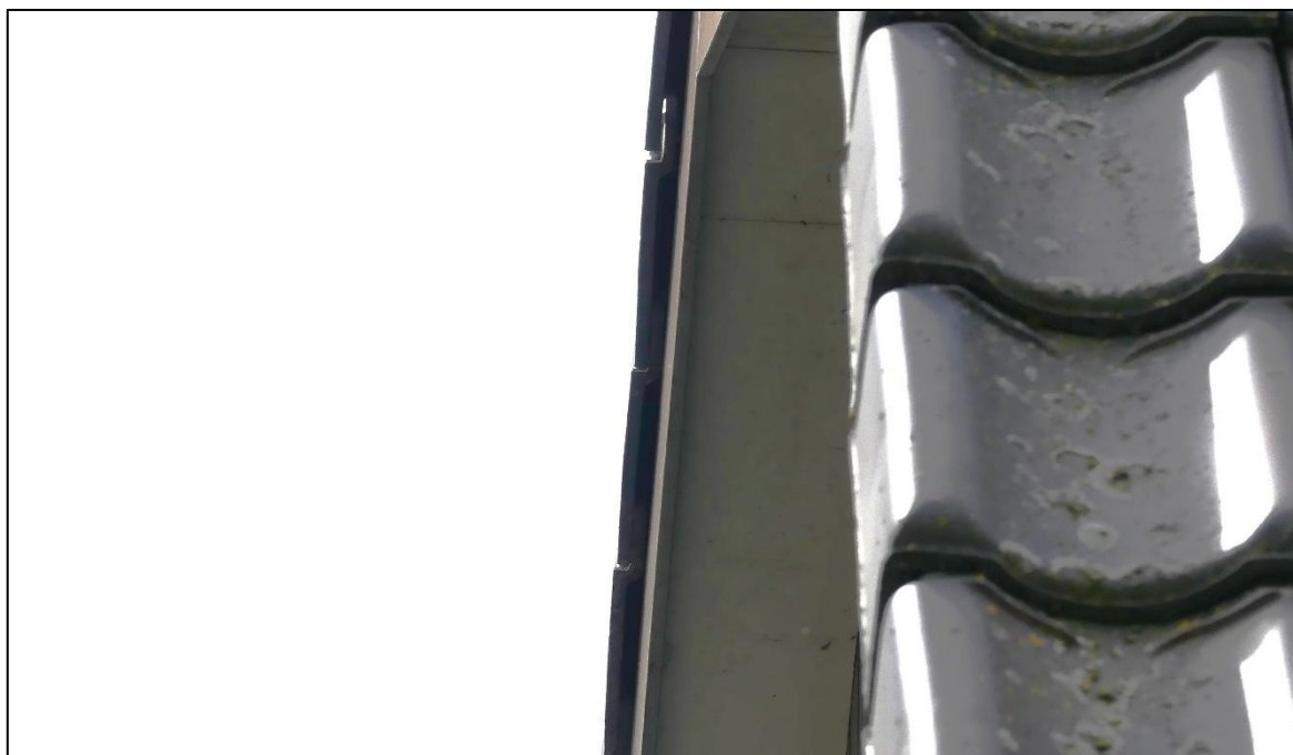
Figuur 3.2 Ruimte tussen kantpannen aan de zuidzijde van de bedrijfswoning.
