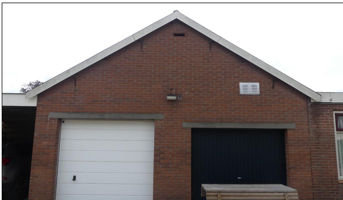
Figuur 3.3 Zolderruimte van de te slopen schuur is toegankelijk middels een ontbrekende baksteen bij de nok.
