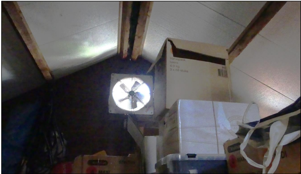
Figuur 3.4 Zolderruimte van de te slopen schuur wordt momenteel gebruikt als opslagruimte.
