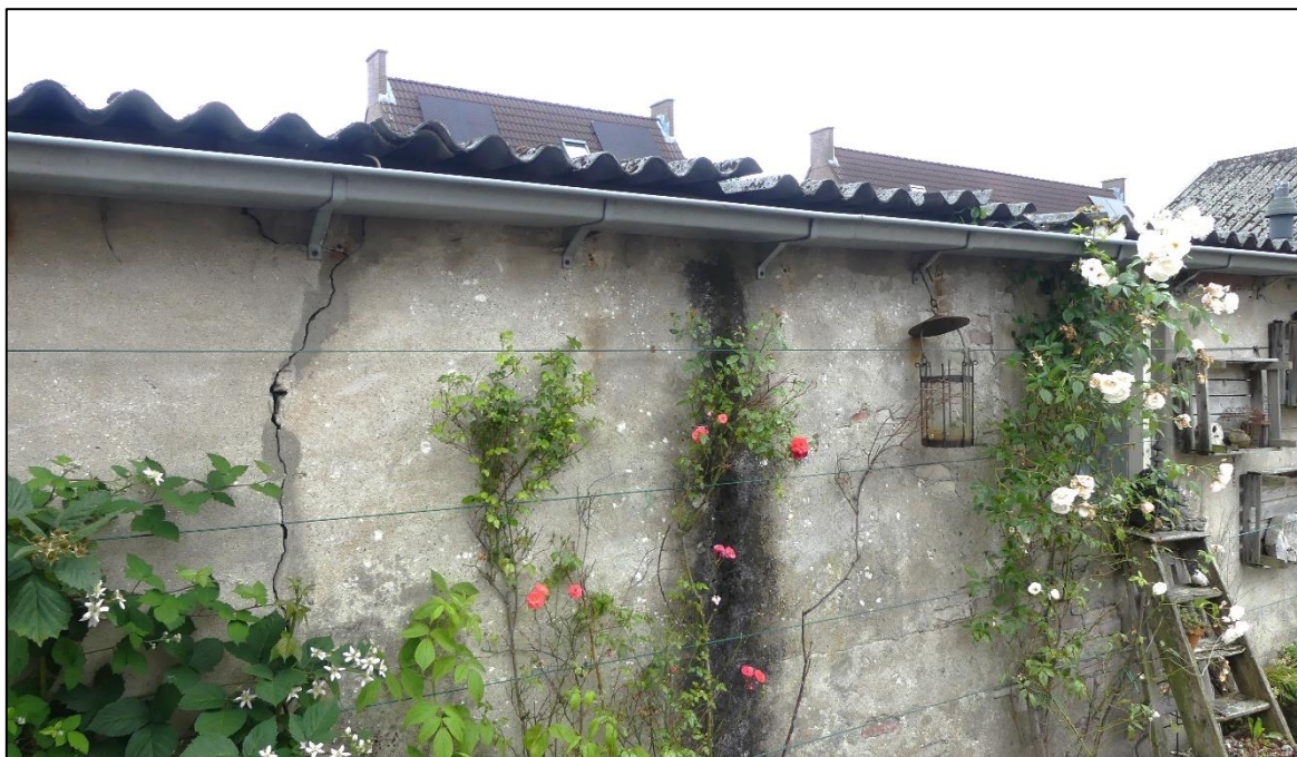
Figuur 3.5 De westzijde van het te slopen horecagebouw bevat een golfplaten dak welke ruimte biedt voor nestlocaties van huismussen.
