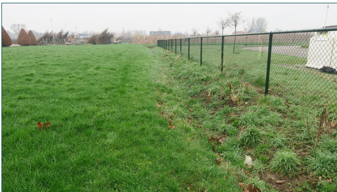
Figuur 4 Op den planlocatie is aan de oostzijde een ondiepe, niet-watervoerende greppel gelegen.
