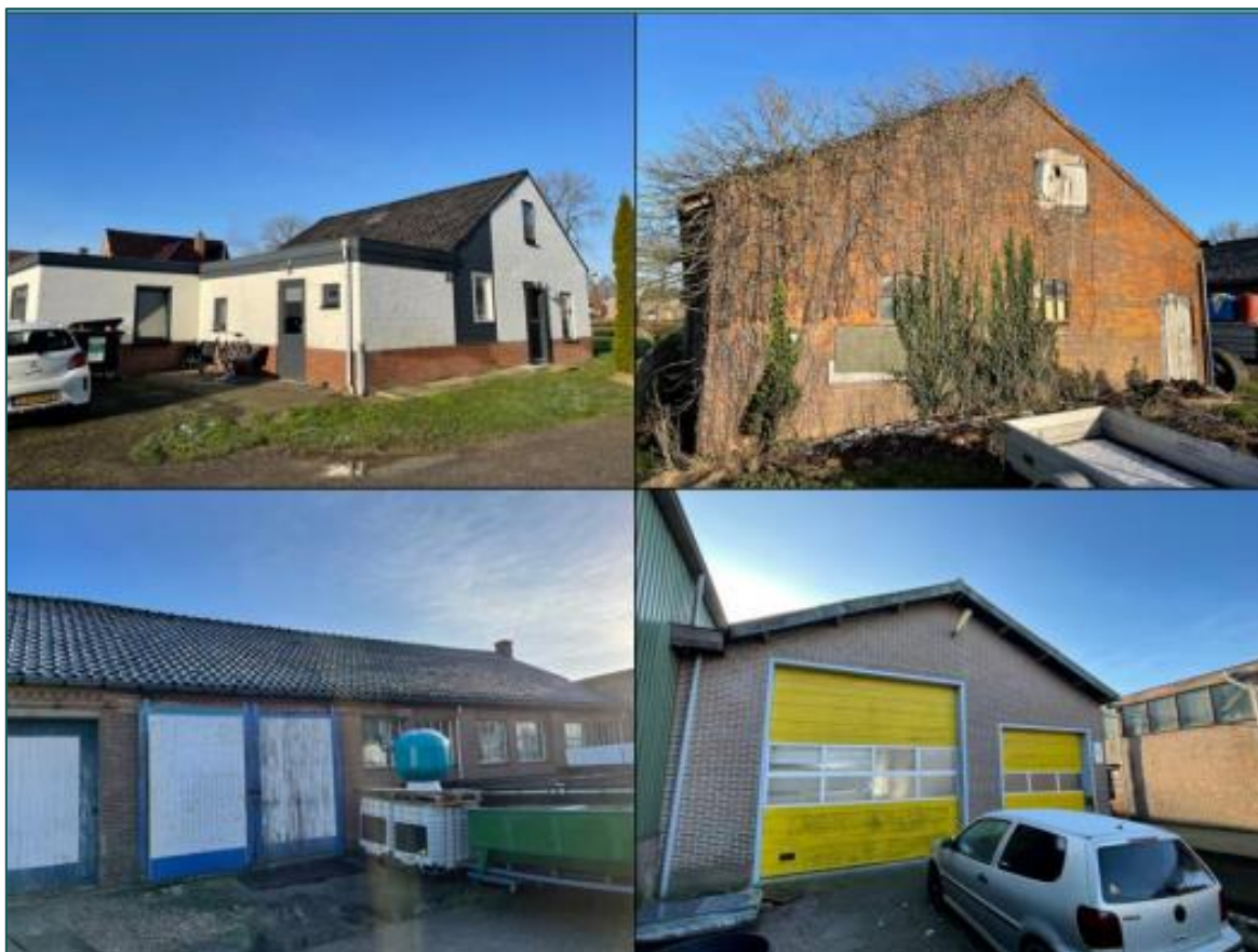
Figuur 1.2 De te slopen bebouwing in het plangebied betreffen een woning en drie schuren.
