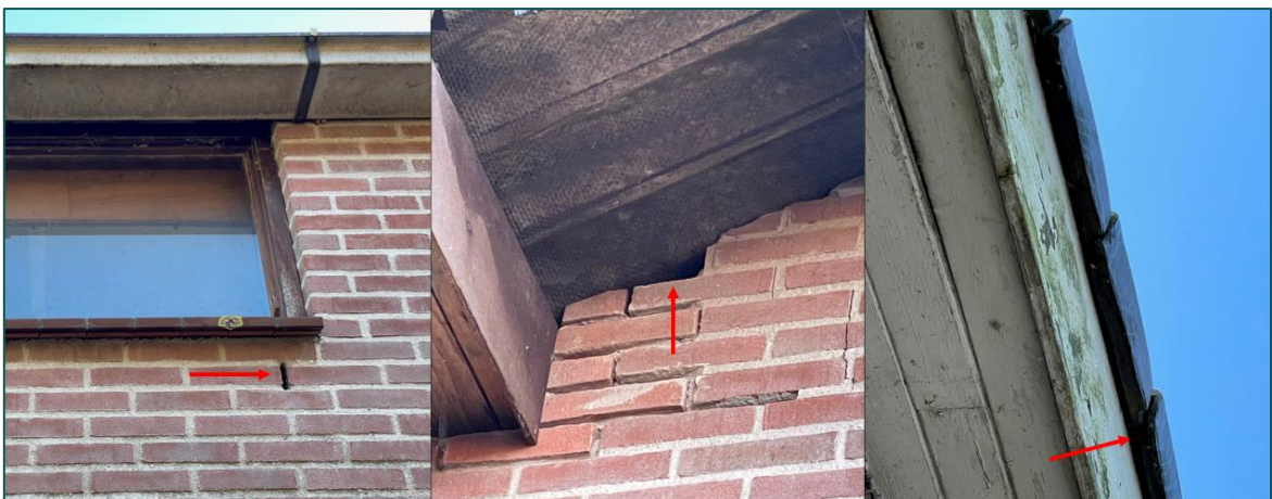
Figuur 3.2 Verschillende openingen in de bebouwing (rode pijlen) waar vleermuizen toegang tot de dak- en spouwruimte kunnen vinden.
