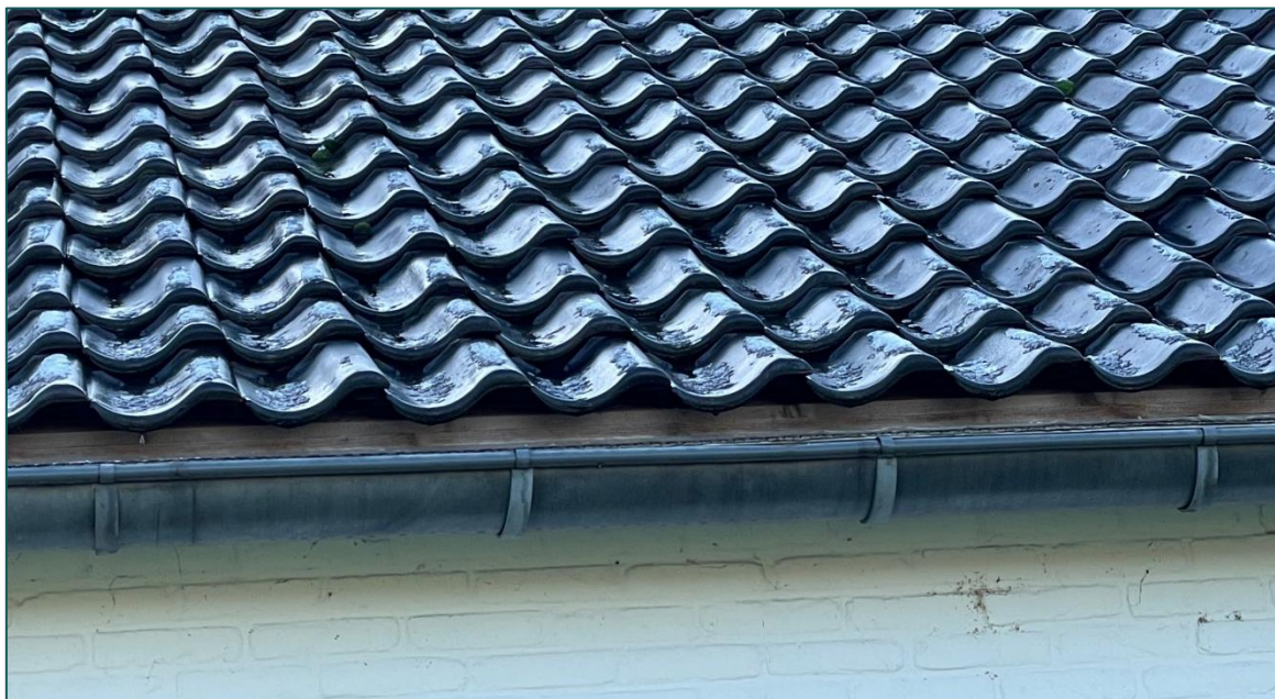
Figuur 3.5 De daken van de te saneren bebouwing bevatten dakpannen met geschikte dakgootconstructies. Zoals zichtbaar is er ook geen sprake van vogelschroot.
