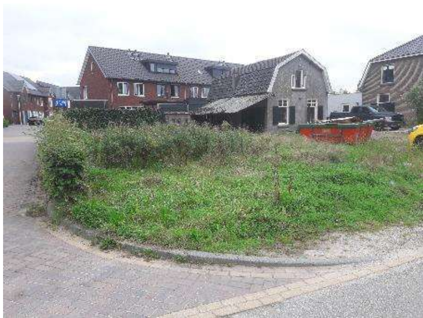
Foto 3: Perceel 2030 met de aanwezige vervallen woning, schuur en overkapping.
