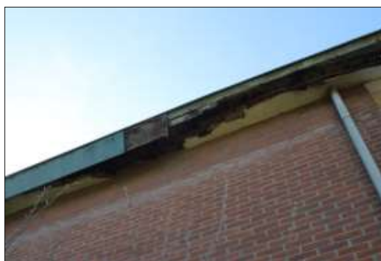
Foto's 5 en 6. Links de spouwvoegen in de muur aan de oostzijde van het gebouw. Rechts de loslatende boeiboorden onder het dak aan de noordzijde van het gebouw.
