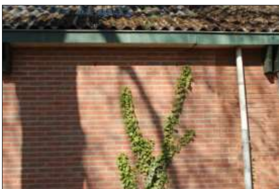
Foto's 5 en 6. Links de spouwvoegen in de muur aan de oostzijde van het gebouw. Rechts de loslatende boeiboorden onder het dak aan de noordzijde van het gebouw.
