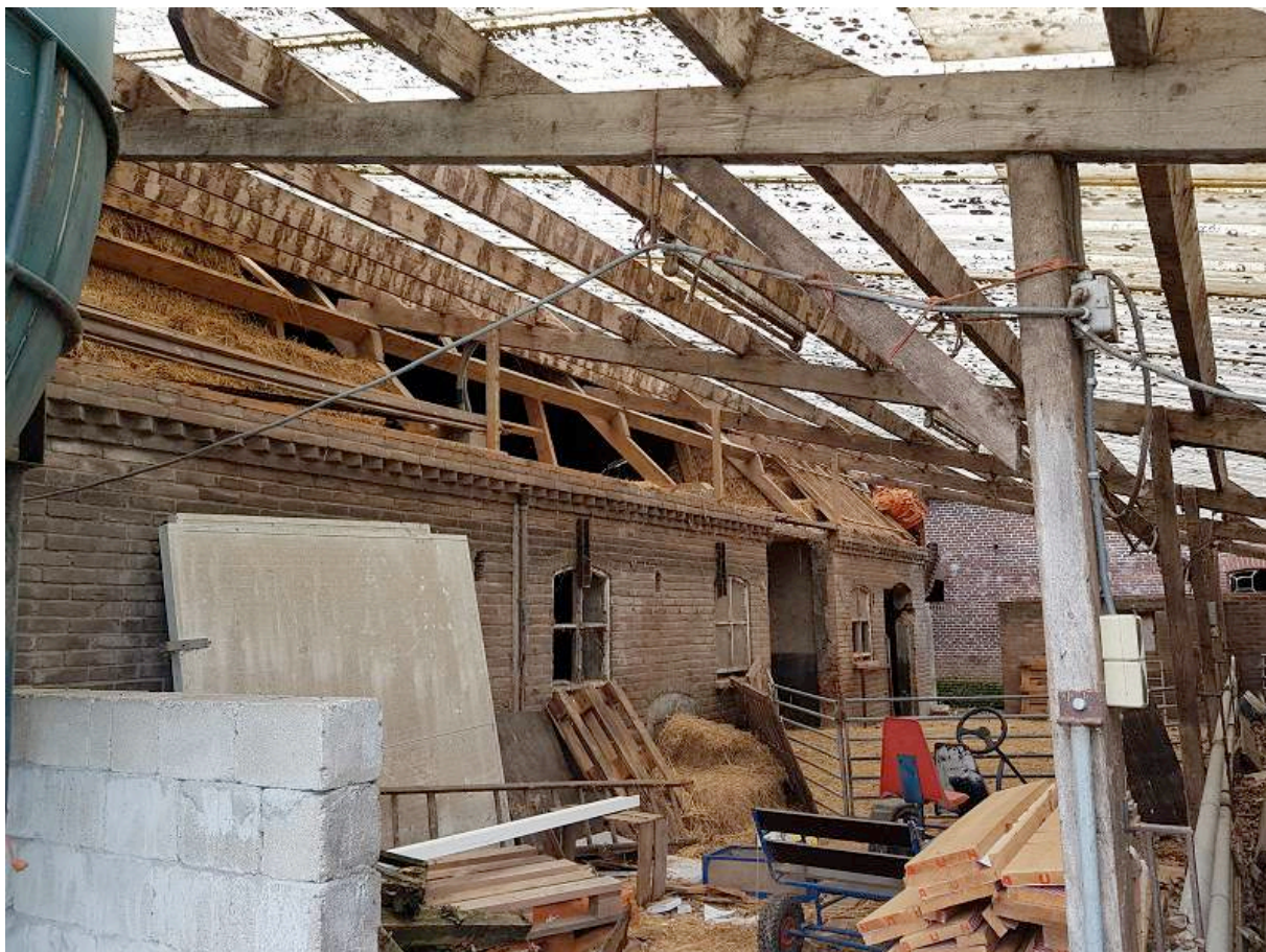
Tussenafdak en de noordelijke gevel van de zuidelijke opstal.
