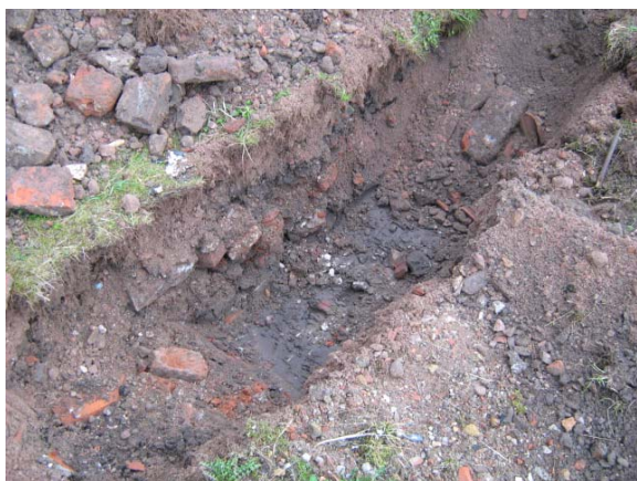
Foto 4: Inspectiesleuf 2 (volledig paksteenhoudend puin)
