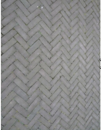
auto-ontsluiting gebakken klinkers
