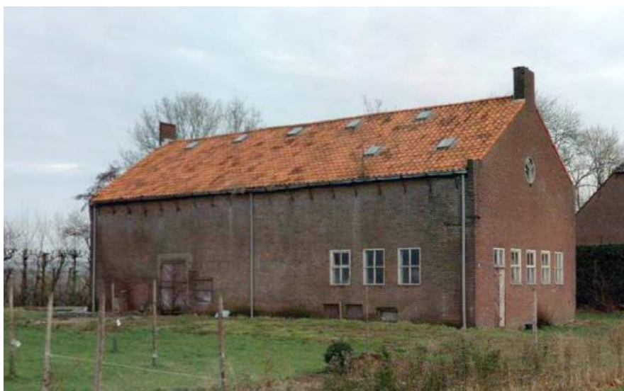
Het koelhuis gezien vanaf de Keizerstraat, bron: VanWestreenen
