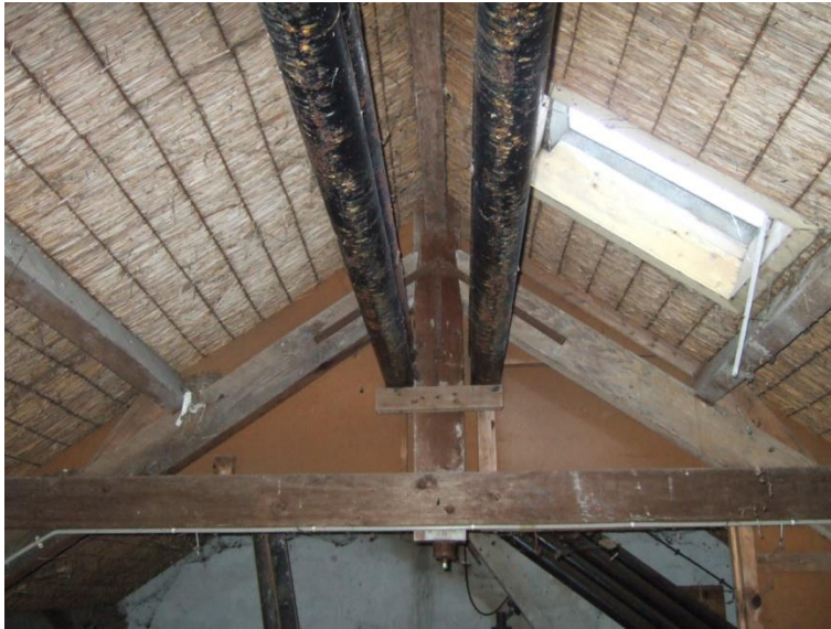
Zolderverdieping: de kapconstructie met een spant en de leidingen van de luchttoevoer.
