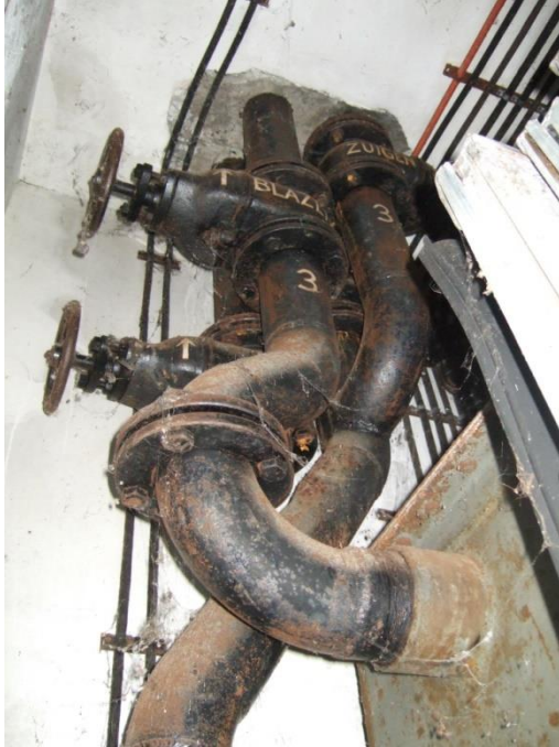
Links: de nog aanwezige installatie voor de luchttoevoer in de koelcellen. Rechts: de houten toegangsdeur naar de koelcel.
