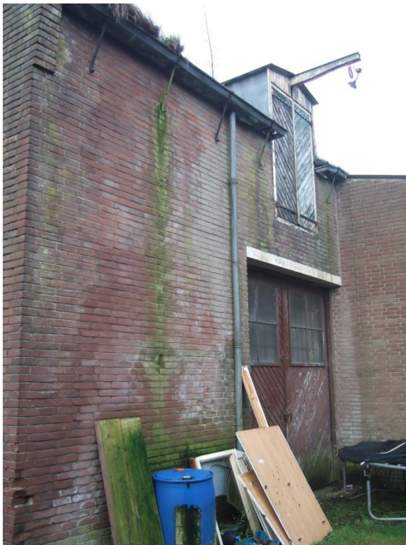
Rechter zijgevel met geheel rechts een deel van de aanbouw.
