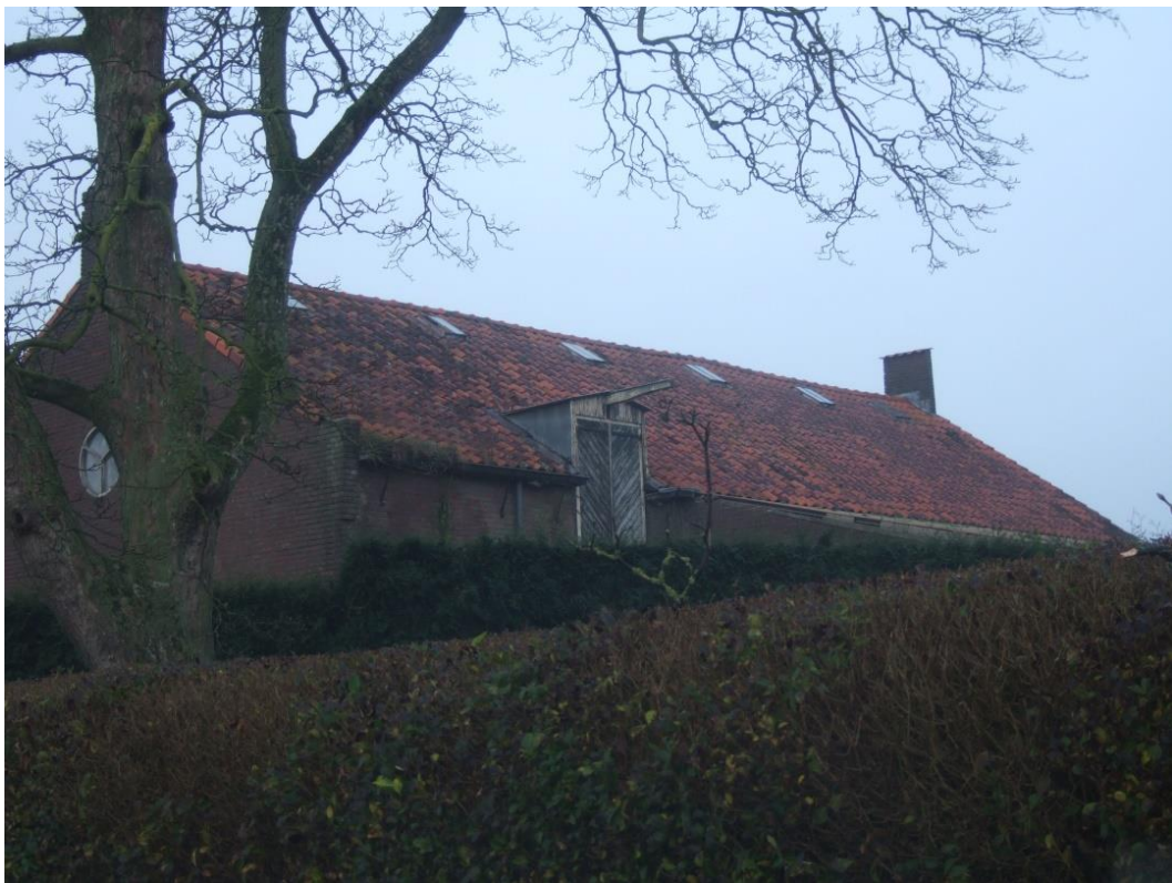
Rechter dakvlak gezien vanaf de Keizerstraat.
