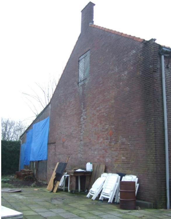
Achtergevel met geheel links de niet oorspronkelijke aanbouw.
