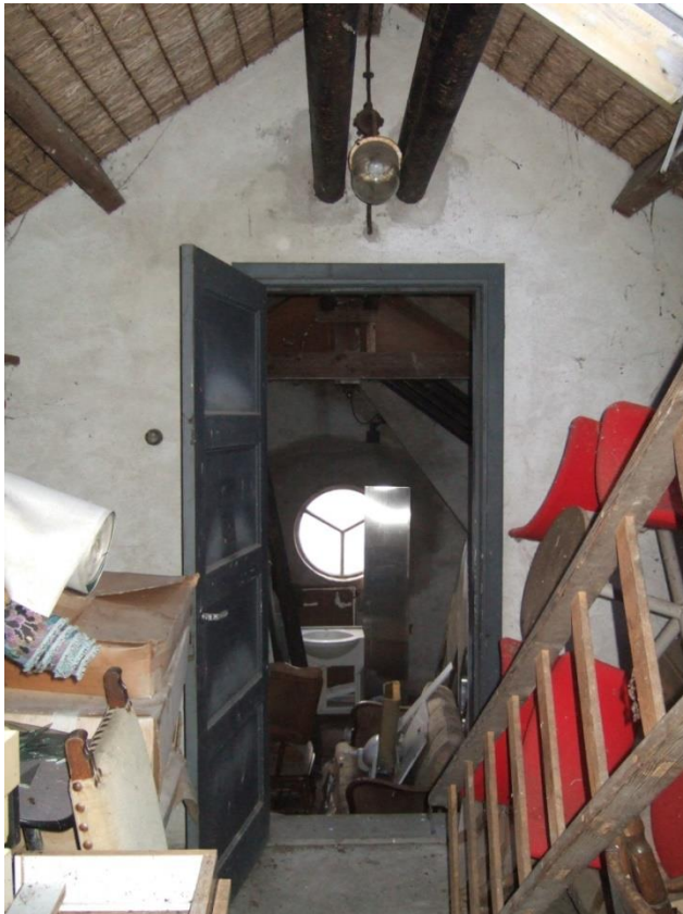
Het vloerniveau boven de koelcellen ligt hoger ten opzichte van de vloer boven de ruimte direct achter de voorgevel.
