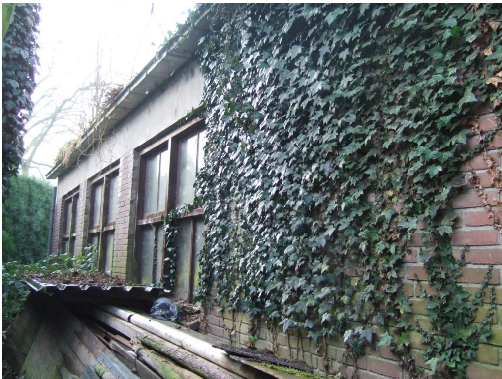
Zijgevel van de aanbouw tegen de rechter zijgevel.
