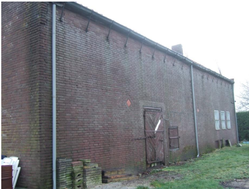
Linker zijgevel. De deur geeft toegang tot de achterste koelcel.
