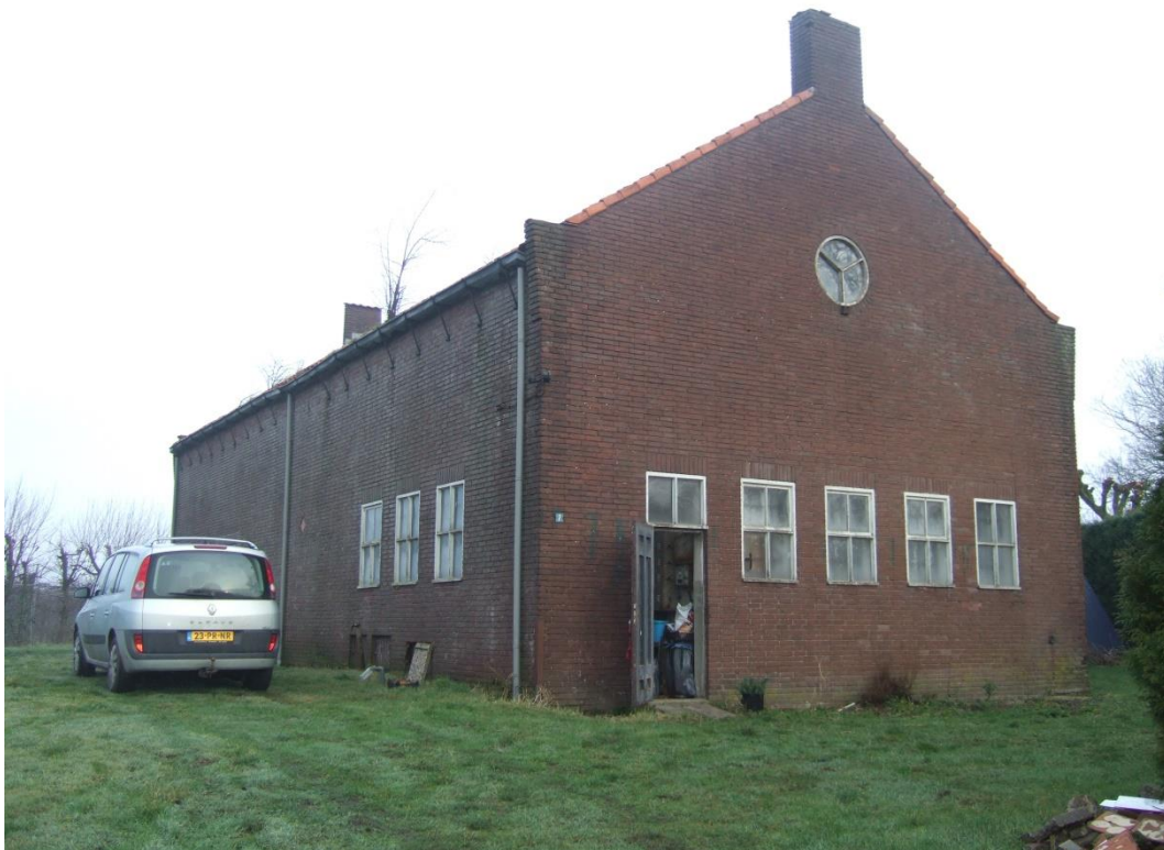
Het koelhuis gezien vanaf de Keizerstraat.
