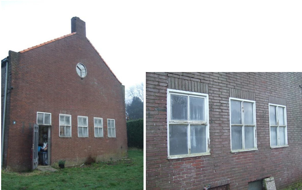
Links: voorgevel. Rechts betonnen ramen in de linker zijgevel.
