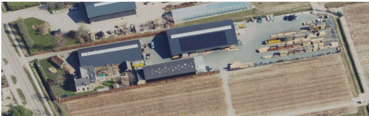
Afbeelding, bouwlocatie Tielsestraat 85c (Bron: Street Smart, 10 maart 2022)
