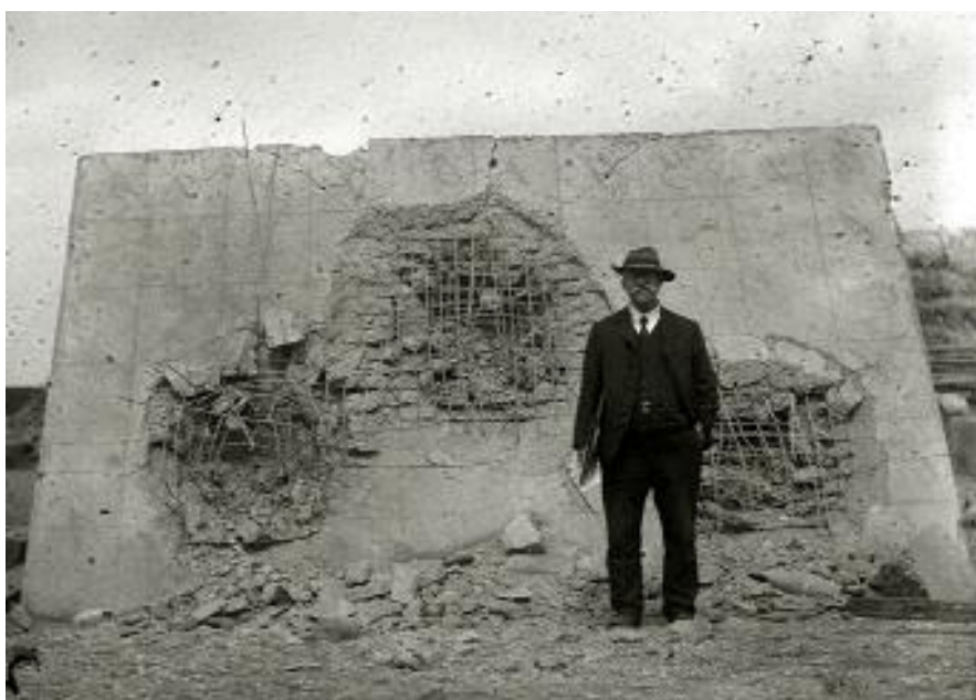
Afb. 13 Resultaat van een schietproef op een schuilplaats van gewapend beton, Oldebroek 1909. De wapeningsnetten zijn duidelijk zichtbaar bij de inslagen, de diepte van de gaten is geringer dan bij ongewapend beton en de constructie is niet gescheurd (ontwricht) zoals die van het ongewapende beton op afb. 2! (inv. nr. 00114365)
