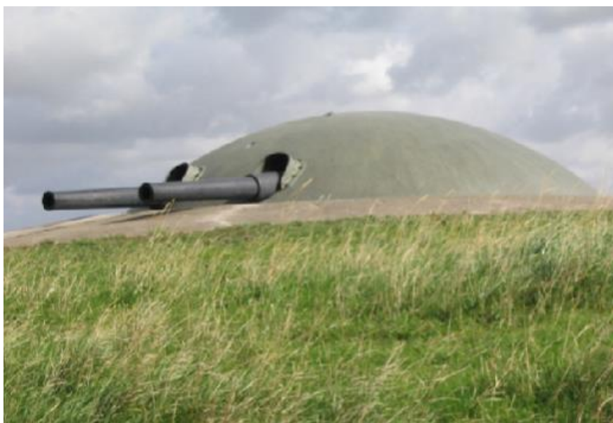
Afb. 8 Gietstalen koepel met twee Krupp 24cm kanonnen van het pantserfort bij Spijkerboor. Foto M. Verhoeks.
