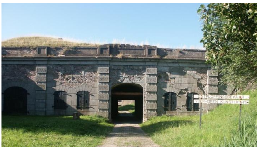
Afb. 10. Het in brikkenbeton met een gepleisterde afwerking en klassieke details uitgevoerde poortgebouw van fort Sabina. Foto: M. Verhoeks
