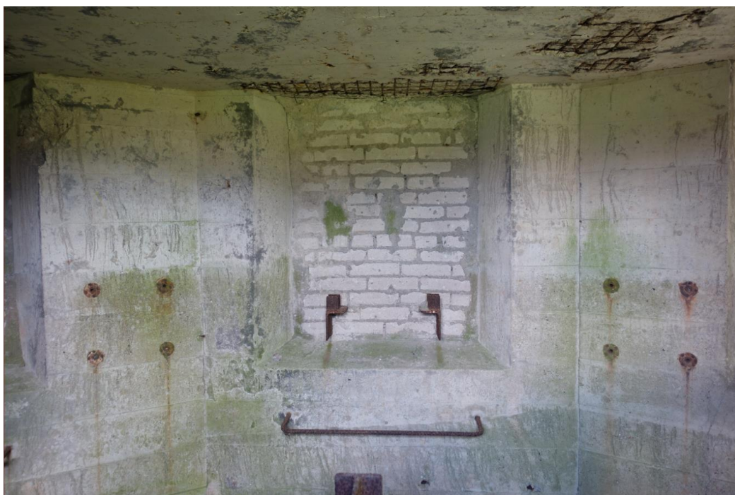
Afb. 39 Interieur oostelijke kazemat met zicht op het middelste dichtgemetselde schietgat. Links en rechts van het linker schietgat zijn vier bevestigingspunten voor de pomp van de waterkoeling van het machinegeweer zichtbaar. Onder het schietgat is een beugel voor de voeten van de schutter aanwezig. In het plafond is de wapening deels zichtbaar geworden. Hier zijn echter geen bevestigingen voor ophanging van de afzuiging te zien. FH MAB 2021
