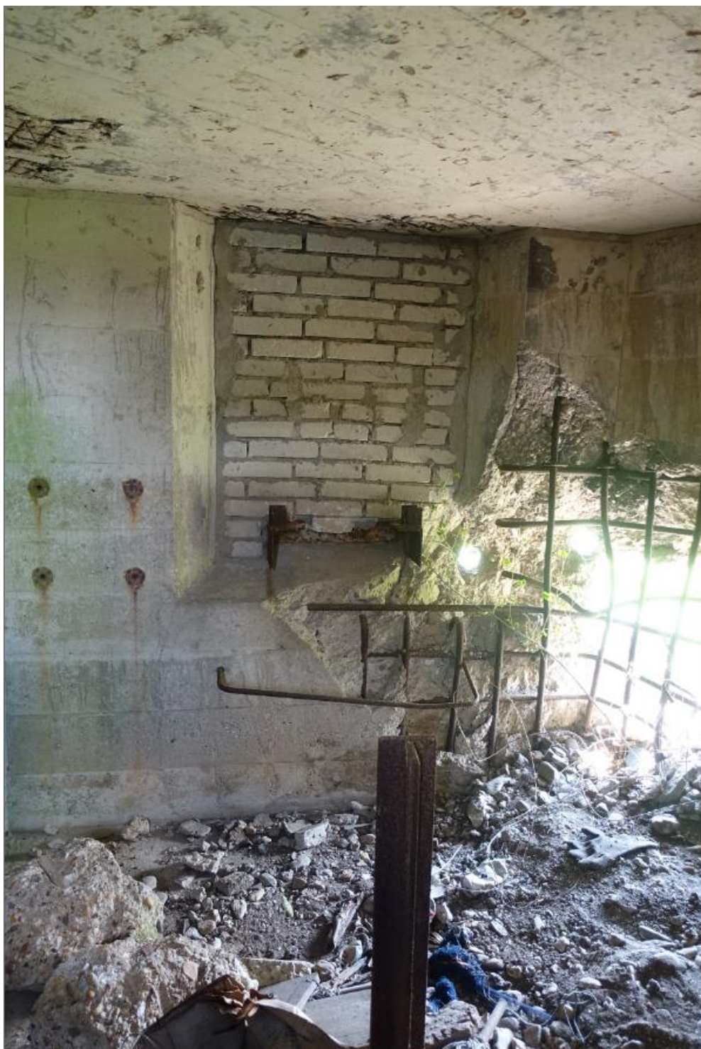
Afb. 40 Interieur oostelijke kazemat met zicht op het rechter dichtgemetselde schietgat. Links van het schietgat zijn vier bevestigingspunten voor de pomp van de waterkoeling van het machinegeweer zichtbaar. Onder het schietgat is een beugel voor de voeten van de schutter aanwezig. De onderhoek is hier op de wapening na volledig weggeschoten. In het plafond is de wapening deels zichtbaar geworden. Hier zijn echter geen bevestigingen voor ophanging van de afzuiging te zien. FH MAB 2021
