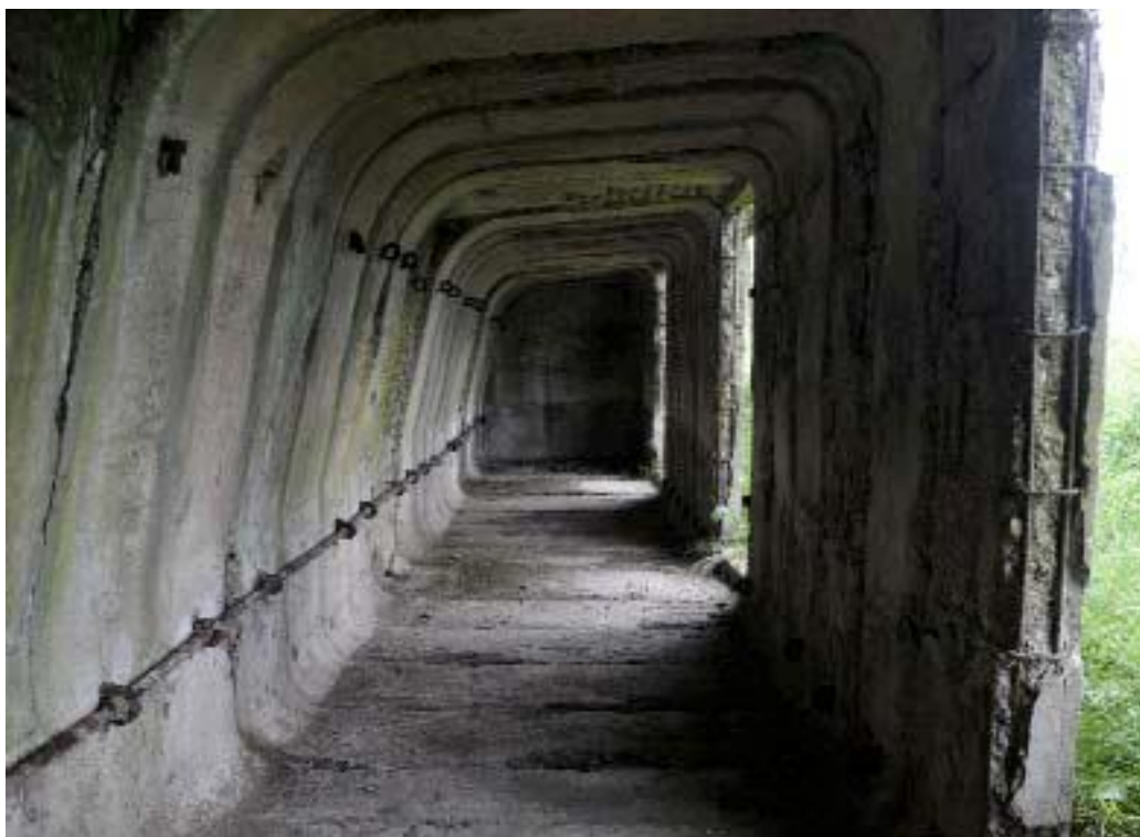
Afb. 14 Schuilplaats 1916. Goed te zien is hoe de ringsegmenten van gewapend beton bij elkaar worden gehouden door staalkabels. Deze schuilplaats ligt aan de gedekte gemeenschapsweg tussen fort Honswijk en het Werk aan de Korte Uitweg. De weg liep parallel aan een inundatiekanaal en maakte deel uit van de verdediging van het Lekaces van de Nieuwe Hollandse Waterlinie. (foto Marius van Leeuwen)
