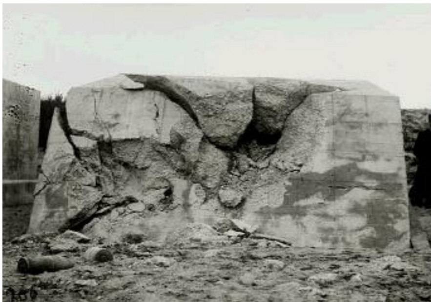
Afb.12 Resultaat van een schietproef op een schuilplaats van ongewapend beton, Oldebroek 1909. links op de voorgrond twee pantsergranaten 21 cm. (inv. nr. 00110210)
