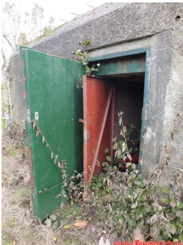
Afb. 18. De achterzijde met toegang van een SZW FR kazemat in de Betuwe-stelling. De kazemat is na de oorlog tijdelijk als munitieopslag gebruikt waarvoor de deuropening is vergroot. www.bunkerinfo.nl
