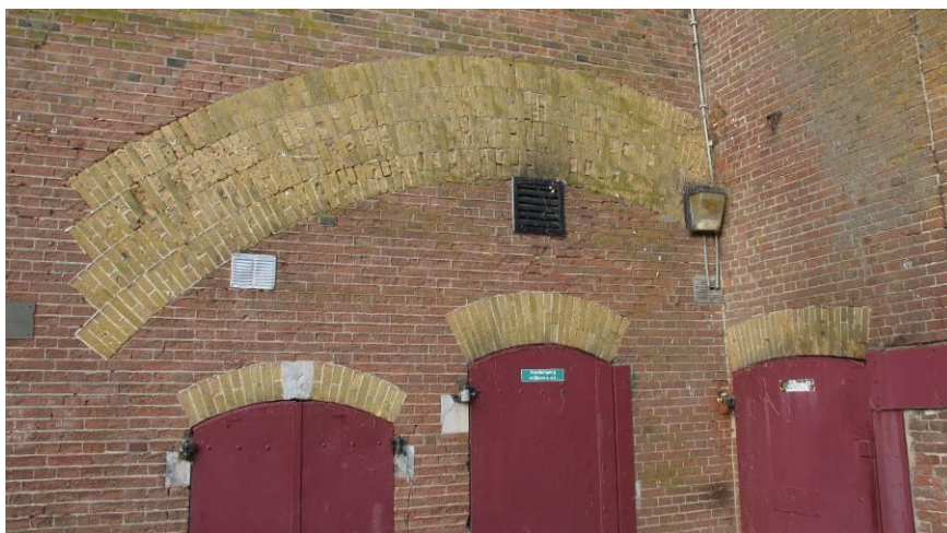
Afb. 9 Detail van de gevel van het bomvrije projectielen en kruitmagazijn van Hellevoetsluis met vier, steeds hoge schillen van de gewelven in gele steen. FH MAB 2010
