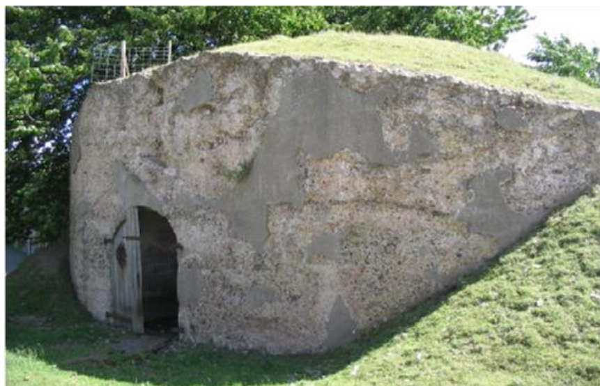
Afb. 11 De gebogen in brikkenbeton met een cementlaag uitgevoerde gevel van een remise van fort Sabina. Foto M. Verhoeks
