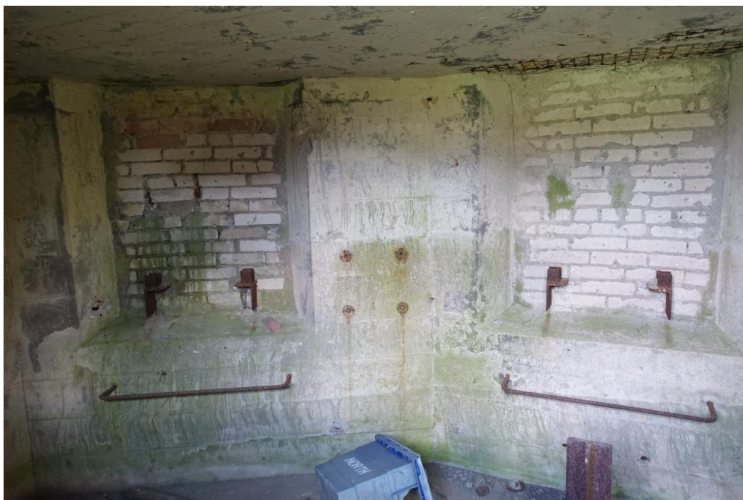
Afb. 38 Interieur oostelijke kazemat met zicht op de twee dichtgemetselde schietgaten. Rechts van het linker schietgat zijn vier bevestigingspunten voor de pomp van de waterkoeling van het machinegeweer zichtbaar. Onder het schietgat is een beugel voor de voeten van de schutter aanwezig. In het schietgat zijn de beugels van de afuit nog aanwezig. FH MAB 2021
