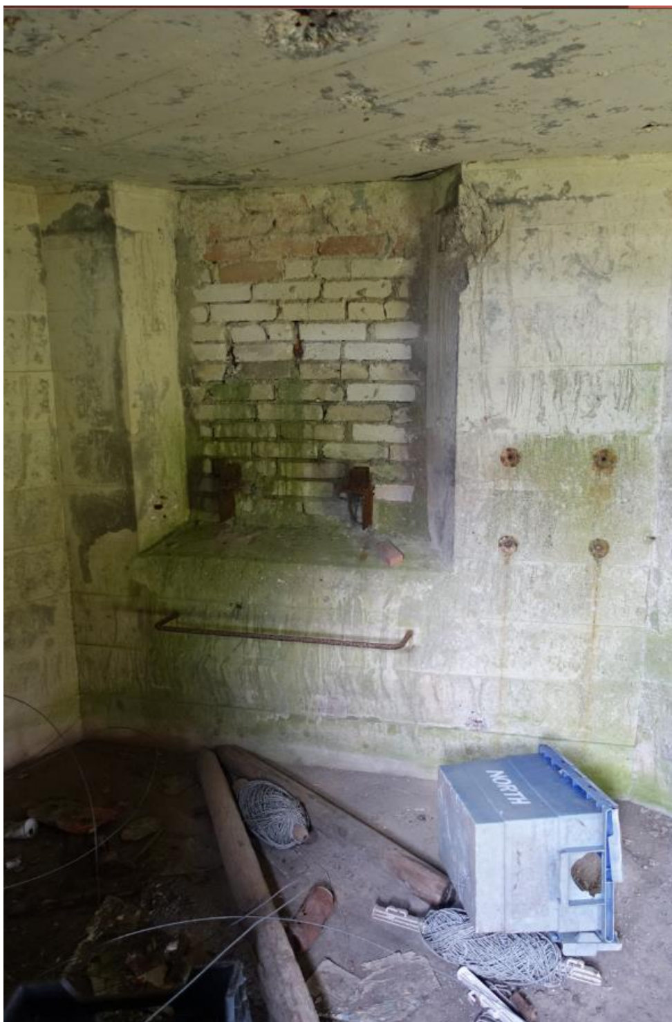
Afb. 43 Interieur oostelijke kazemat met zicht op het linker dichtgemetselde schietgat. Rechts van het schietgat zijn vier bevestigingspunten voor de pomp van de waterkoeling van het machinegeweer zichtbaar. Onder het schietgat is een beugel voor de voeten van de schutter aanwezig. De onderhoek is hier op de wapening na volledig weggeschoten. In het plafond is schade door scherven zichtbaar. Hier zijn echter geen bevestigingen voor ophanging van de afzuiging te zien. FH MAB 2021
