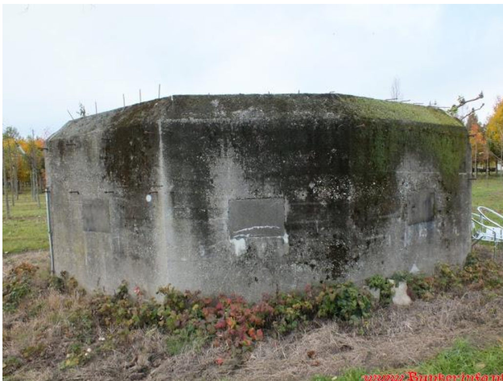
Afb. 17. Een SZW FR kazemat in de Betuwe-stelling. www.bunkerinfo.nl
