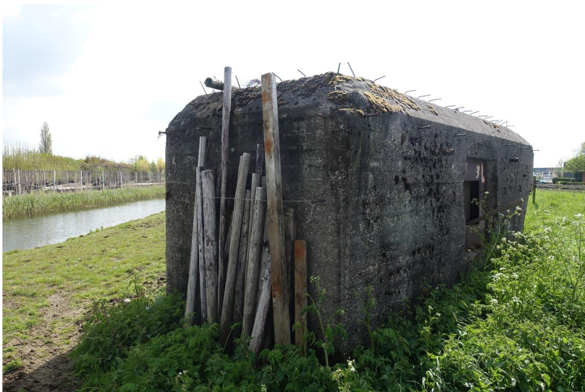
Afb. 34: De oostelijke kazemat vanuit het westen gezien. FH MAB 2021
