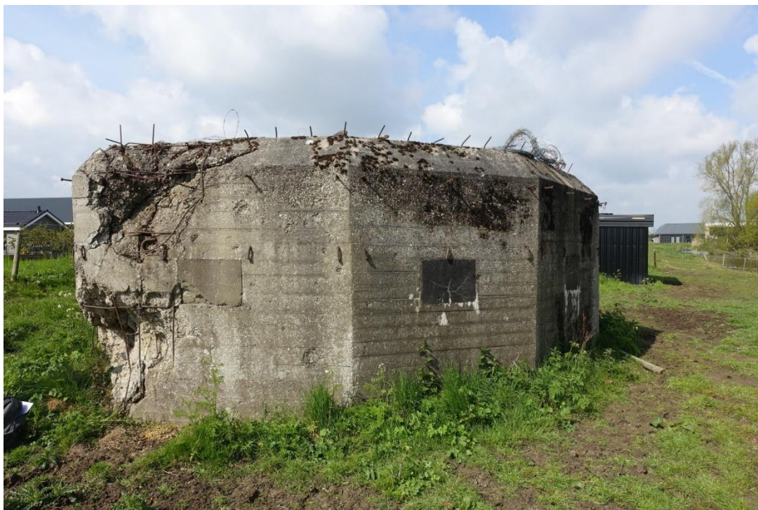
Afb. 33: De oostelijke kazemat vanuit het oosten gezien. FH MAB 2021
