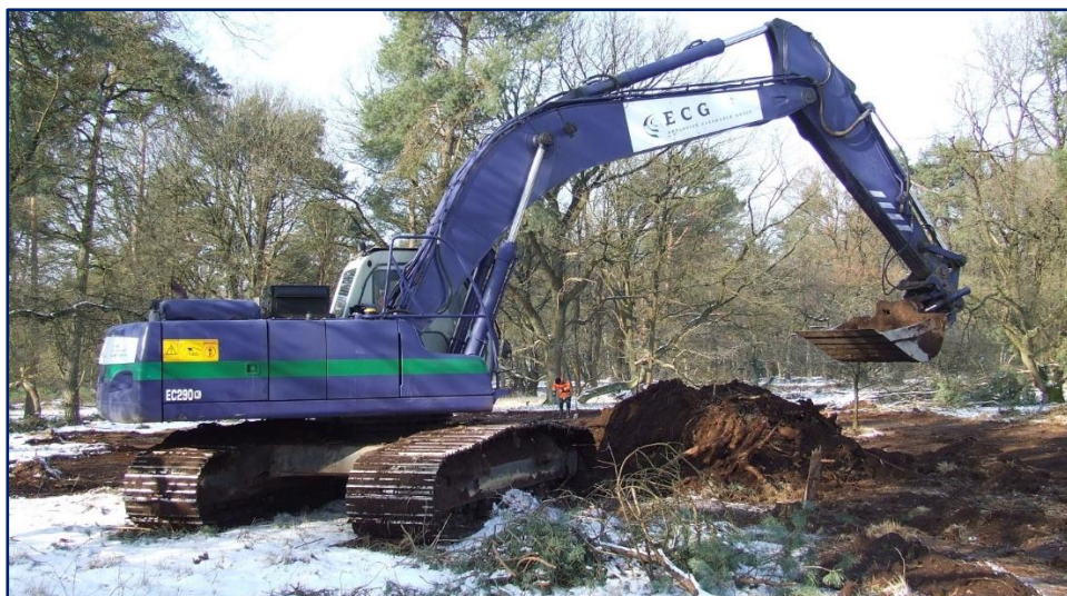
Figuur 2: Gecontroleerd ontgraven.
