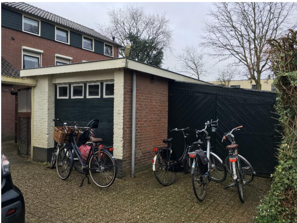
Figuur 4 Om de ontwikkeling te bewerkstelligen wordt het bijgebouw en de aanbouw aan de achterzijde gesaneerd.
