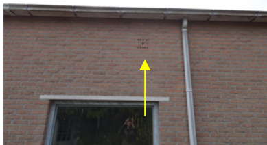
Figuur 5-6. Gaten in de muur die toegang bieden tot de spouwmuur
