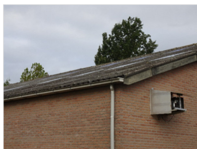
Figuur 5.1 Dakgoot van de noordelijke grote schuur die de huismus toegang geeft tot binnen de schuur.
