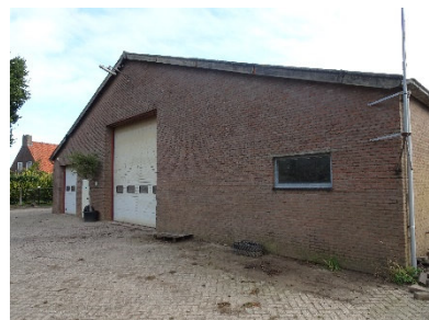
Figuur 2-8. Grote schuur aan de noordkant van de onderzoeklocatie.
