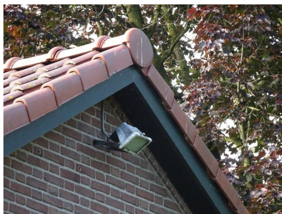
Figuur 5-8. Overhangende dakpannen van het woonhuis.
