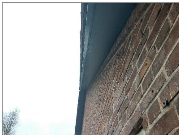
Afbeelding 4.7 | Tussen de dakrand en steenmuur van woning zit een invliegbare, duimbrede ruimte. Daarnaast is er invliegruimte onder de dakpannen.
