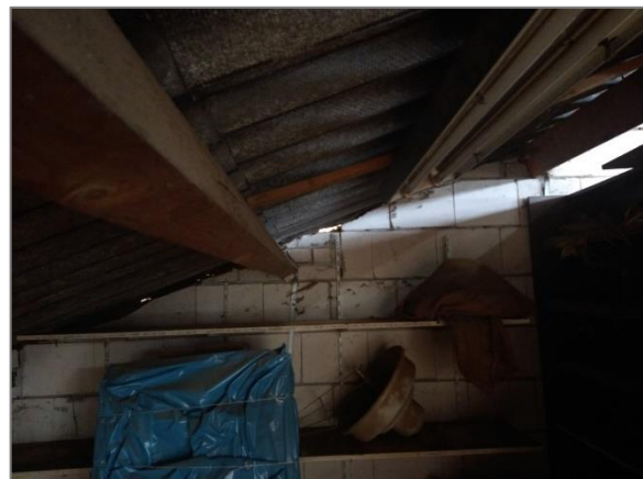
Afbeelding 4.5 | Binnenkant van schuur A
