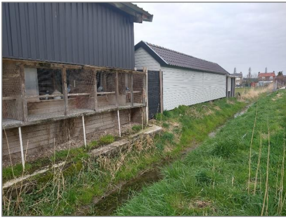
Afbeelding 4.4 | Duiventil en vervallen schuur op de rand van het plangebied (westen)
