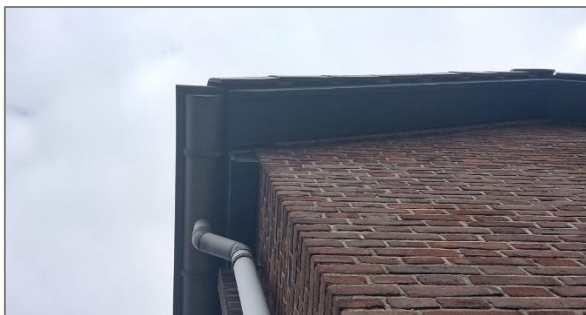
Afbeelding 4.10 | Opening onder dakrand op hoek van woning C
