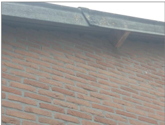
Afbeelding 4.6 | buitenkant van schuur A, met onvolledig afgesloten steenmuur
