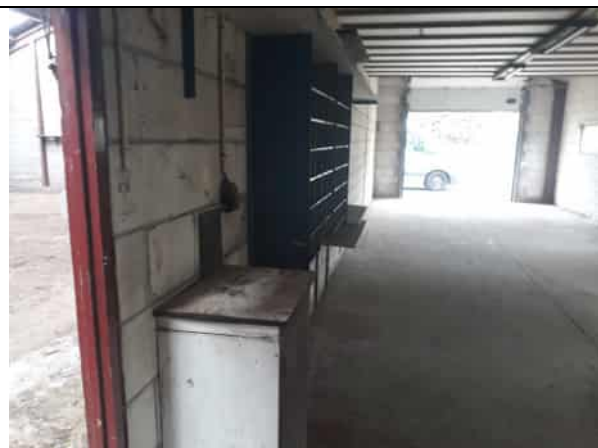
Hal loods (met betonvloer)
