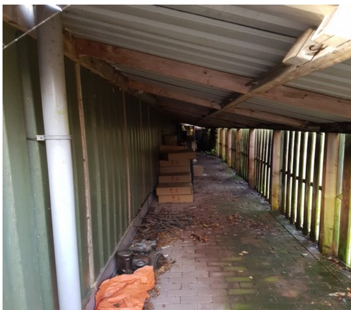
Noordgevel van de opslagloods. Foto: K. van Veen | Ecoresult B.V.
