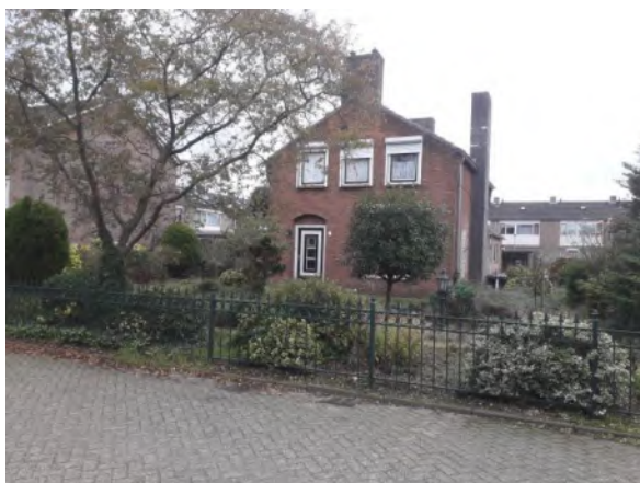
Foto 1: Onderzoekslocatie/ woning vanaf Beukenlaan
