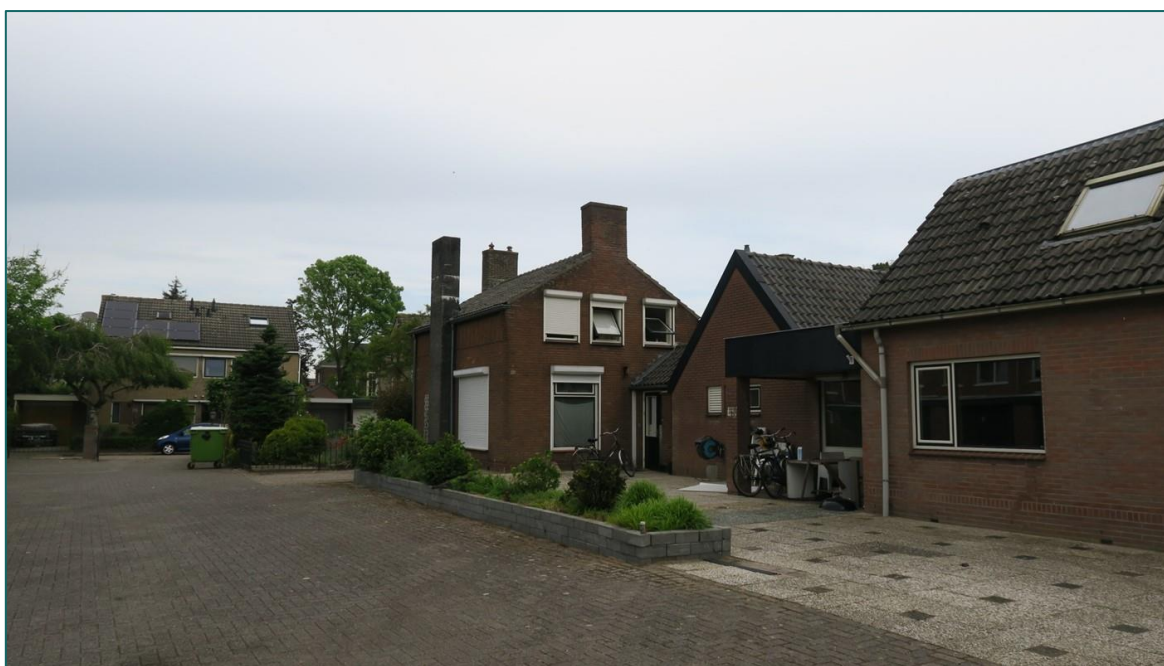
Figuur 4 De bebouwing is opgetrokken uit gemetselde muren met dakpannen zadeldaken.
