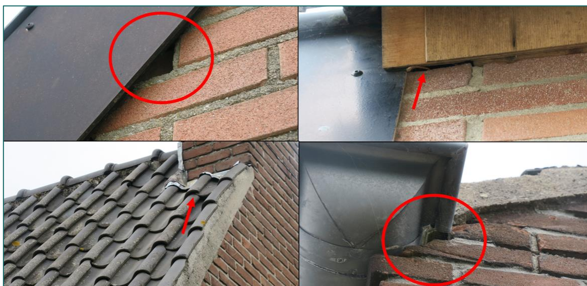
Figuur 3.1 Weergave van de diverse openingen in de bebouwing welke toegang tot de dak- en spouwruimte bieden.
