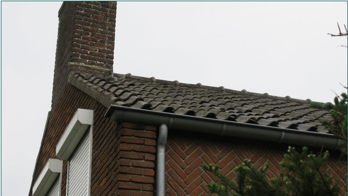
Figuur 3.2 Zichtbaar geschikte dakconstructie met rechtsonder een jaarrond groene haag (zichtbaar op korte afstand).
