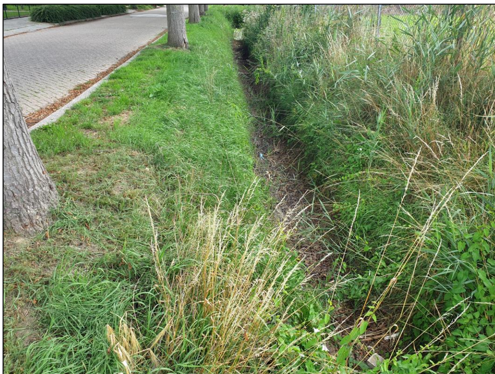
Figuur 2 De aanliggende greppels zijn drooggevallen.
