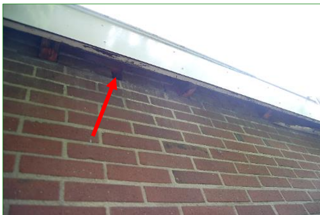
De openingen achter de boeiboorden (oostgevel voormalige burgermeesterswoning) geven toegang tot de spouw (rode pijl) en daarmee mogelijk toegang tot voor vleermuizen geschikte achterliggende ruimtes.
