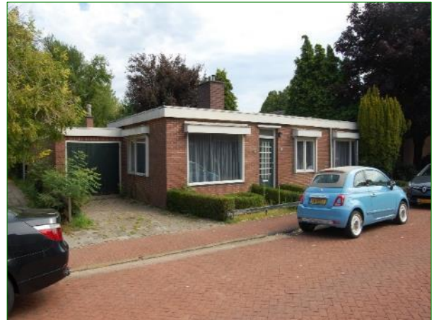
Voorzijde (zuidzijde) voormalige burgemeesterswoning aan de Lambartus van Ingenstraat 2.
