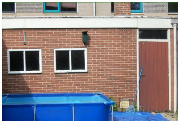
Mezenkast bevestigd aan de oostgevel van de voormalige burgemeesterswoning.
