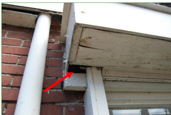
De gaten in de rolluikcassettes (rode pijl) bevestigd aan de oost-, zuid- en westgevel van de voormalige burgemeesterswoning geven mogelijk toegang tot voor Huismussen geschikte achterliggende ruimtes.
