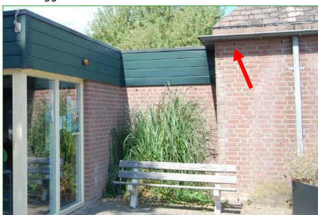
De openingen in de spouwmuur (rode pijl) aan alle zijden van de bebouwing (Lambartus van Ingenstraat 2) geven mogelijk toegang tot voor vleermuizen geschikte achterliggende ruimtes.
