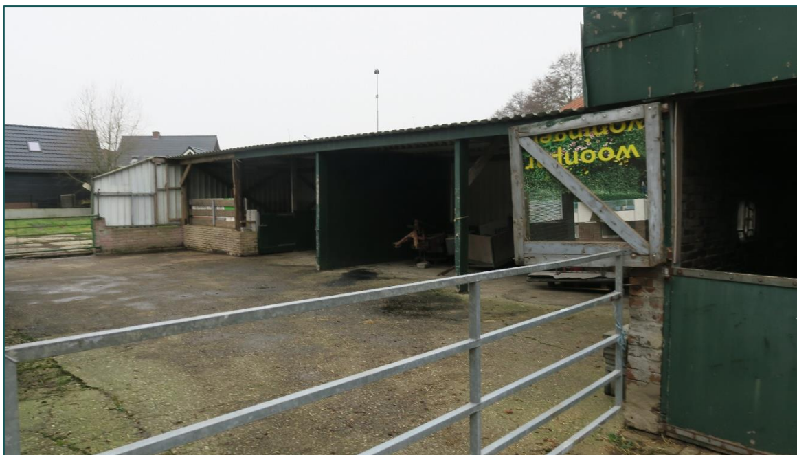
Figuur 2 De bebouwing bestaat uit enkel steens muren en golfplaten daken.
