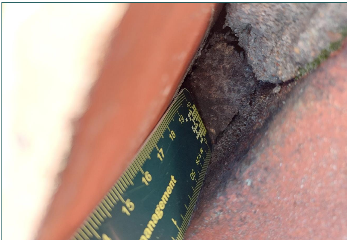
Figuur 3.1 Er is één opening in de specie tussen de kantpannen, deze loopt echter niet door tot de spouw- of dakruimte en is derhalve ongeschikt als verblijfplaats voor vleermuizen.
