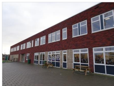
Figuur 2.6 Noordzijde schoolgebouw.
