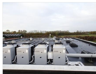
Figuur 2.5. Dak van het schoolgebouw.
