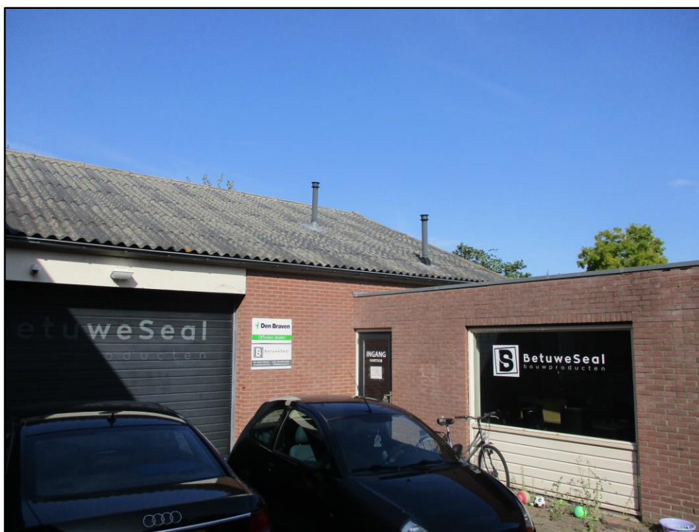
Figuur 2 De schuur/kleine loods op de planlocatie.
