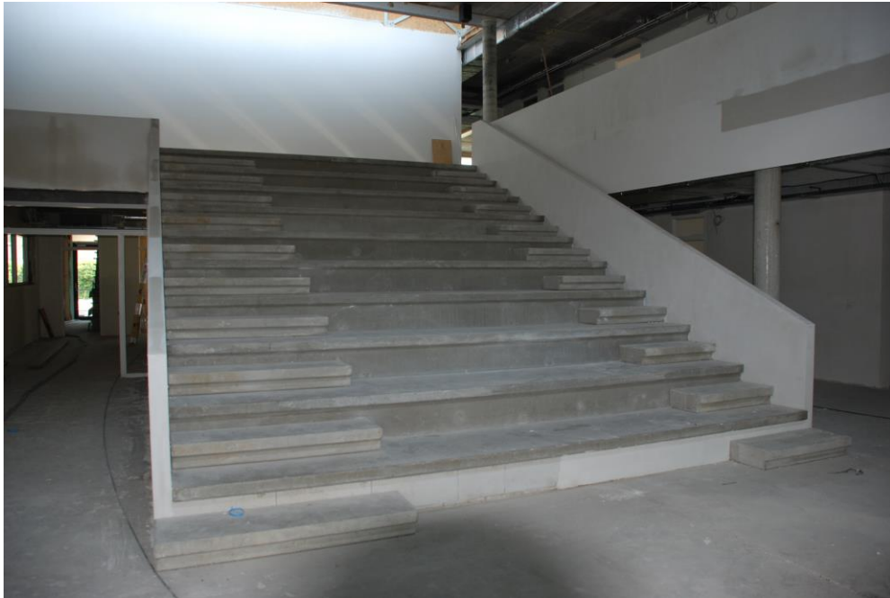
Voorbeeld van een 'open verbindingstrap' tussen begane grond en verdieping
