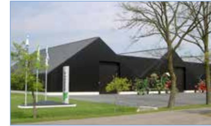
Donkere kleuren gaan beter op in het landschap. Geleding in de hoofdmassa en detaillering van de gevel laten het volume kleiner lijken.
