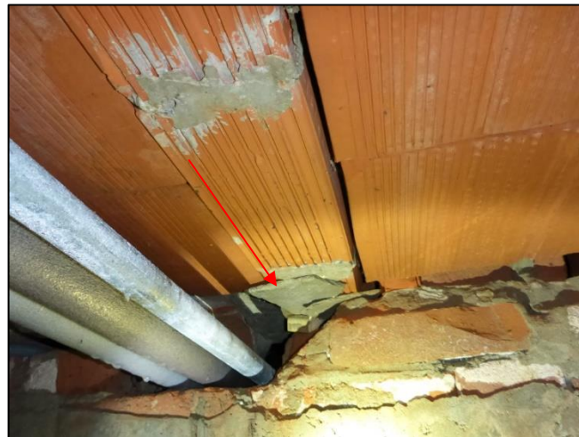
Foto 50: Kelder, Begane grond vloer: Vulplaatjes (M02AA)
