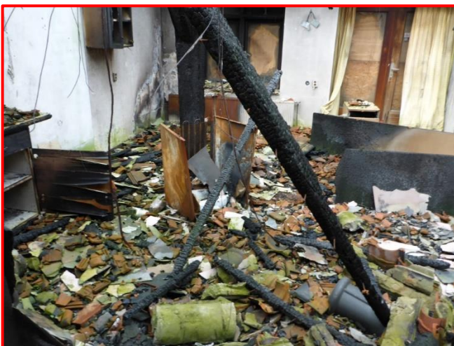
Foto 9: Boerderij, Begane grond: Restanten plafondbeplating (M01AA)
