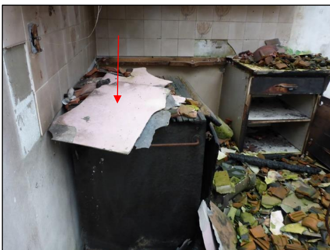
Foto 11: Boerderij, Begane grond: Restanten plafondbeplating (M01AA)
