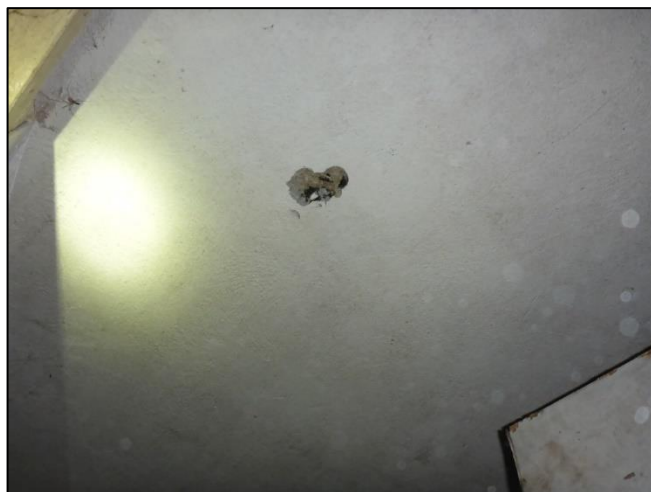
Foto 60: Bijgebouw: Plafondbeplating (Asbestvrij)
