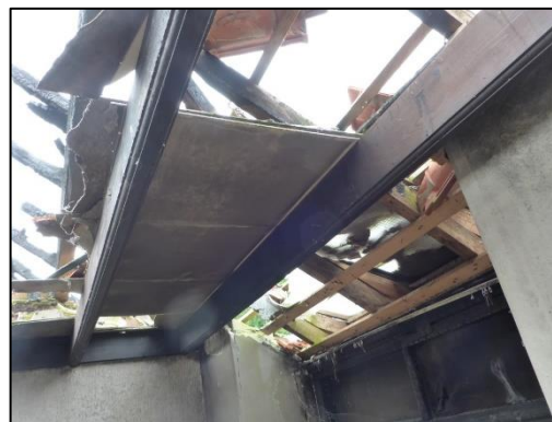
Boerderij, begane grond: Plafondbeplating (M01AZ)
