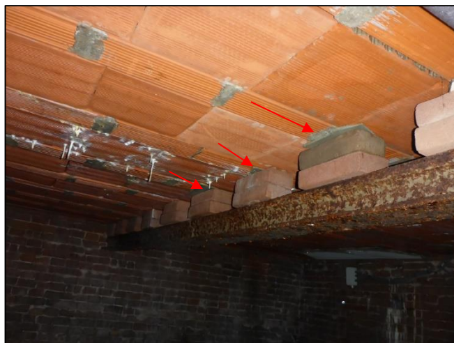
Foto 48: Kelder, Begane grond vloer: Vulplaatjes (M02AA)
