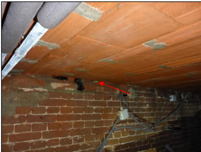
Foto 49: Kelder, Begane grond vloer: Vulplaatjes (M02AA)
