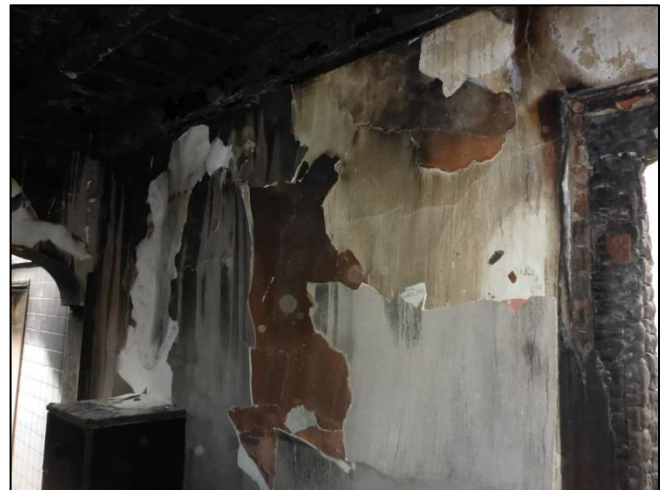
Foto 28: Wandbeplating (Asbestvrij)
