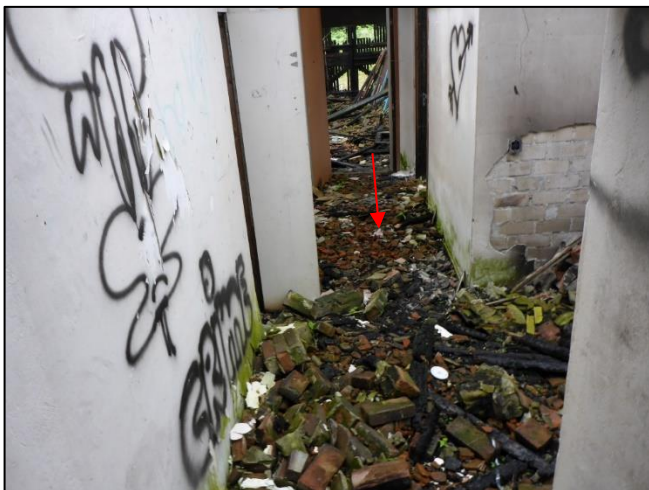
Foto 21: Boerderij, Begane grond: Restanten plafondbeplating (M01AA)
