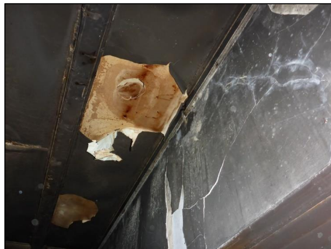
Foto 40: Voorhuis: Plafondbeplating (Asbestvrij)
