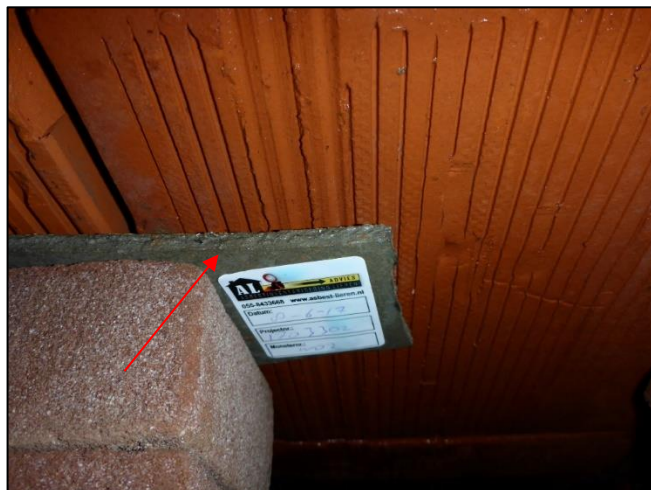
Foto 46: Kelder, Begane grond vloer: Vulplaatjes (M02AA)
