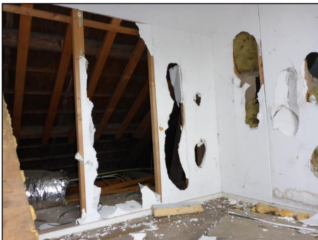
Foto 57: Bijgebouw: Wandbeplating (Gips)
