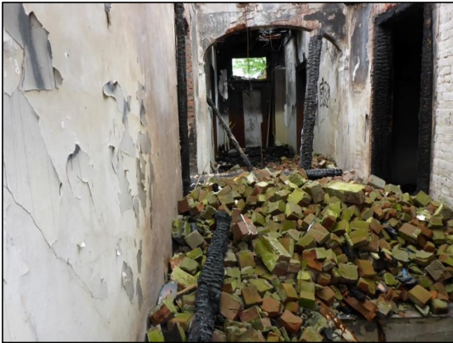
Foto 25: Begane grond (Asbestvrij)
