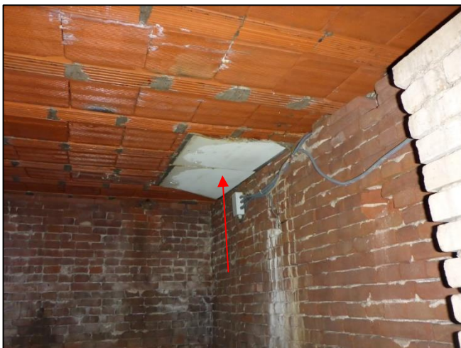
Foto 45: Kelder, Begane grond vloer: Vulplaatjes (M02AA)
