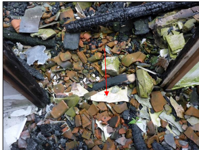
Foto 8: Boerderij, Begane grond: Restanten plafondbeplating (M01AA)
