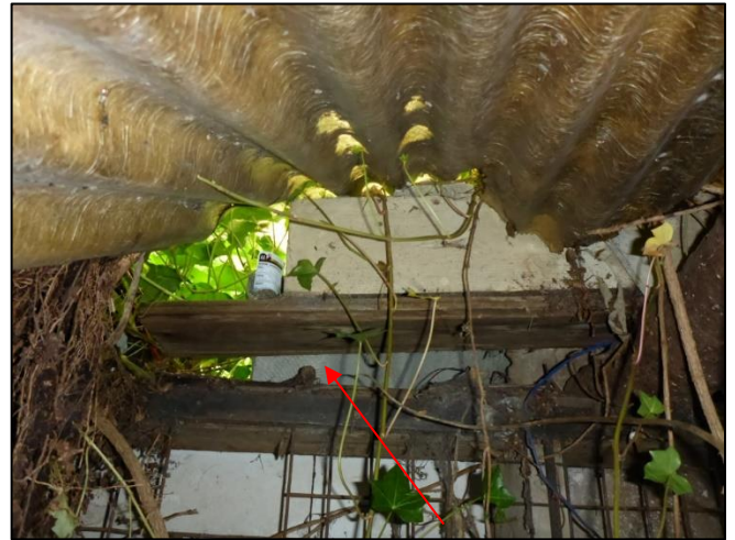
Foto 68: Bijgebouw, Aanbouw: Golfplaten dak (M04AA)
