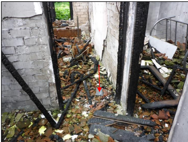
Foto 13: Boerderij, Begane grond: Restanten plafondbeplating (M01AA)
