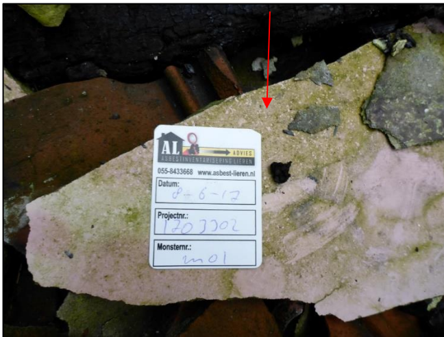
Foto 7: Boerderij, Begane grond: Restanten plafondbeplating (M01AA)
