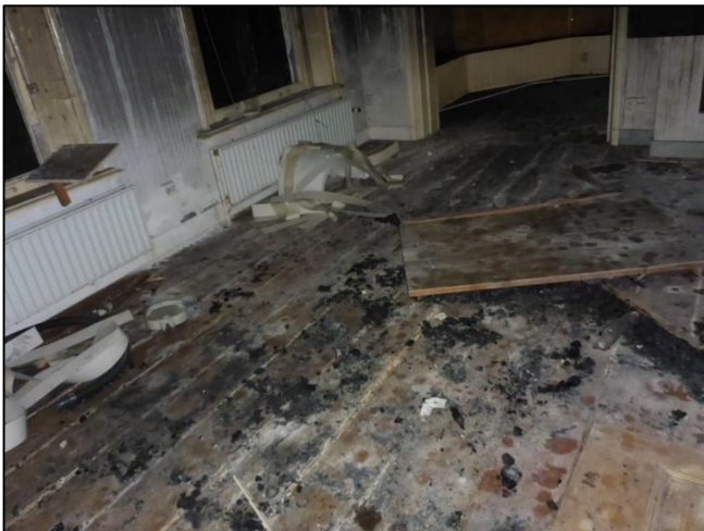
Foto 33: Begane grond: Vloer
