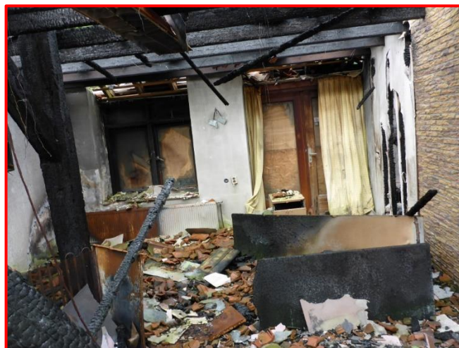
Foto 10: Boerderij, Begane grond: Restanten plafondbeplating (M01AA)
