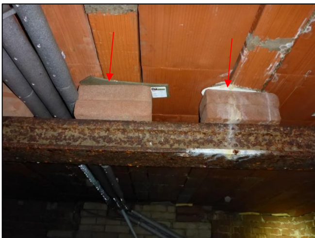
Foto 47: Kelder, Begane grond vloer: Vulplaatjes (M02AA)
