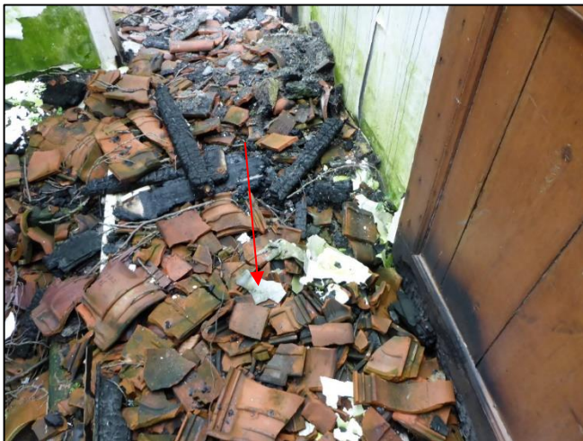
Foto 19: Boerderij, Begane grond: Restanten plafondbeplating (M01AA)
