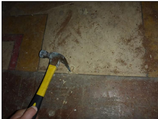
Foto 56: Bijgebouw: Onder vloerafwerking
