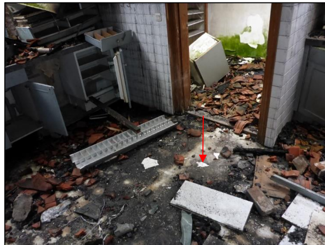
Foto 20: Boerderij, Begane grond: Restanten plafondbeplating (M01AA)
