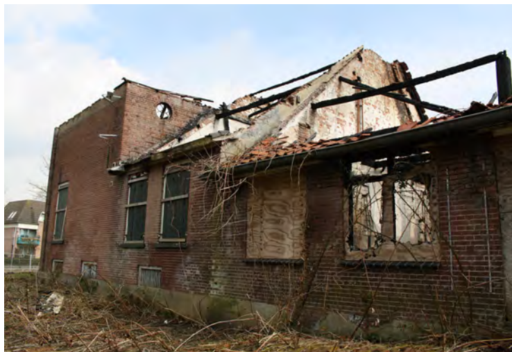
Foto 2: Westgevel boerderij (voorhuis en middenhuis)
