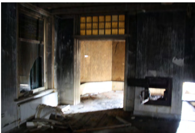
Foto 15: Oostelijke kamer voorhuis en doorgang naar erker.
