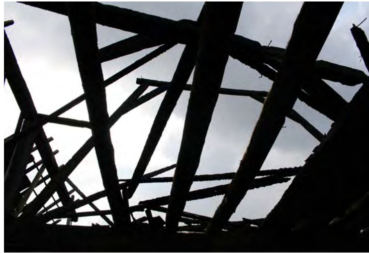
Foto 19: Restanten van de kapconstructie
