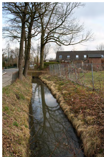
Foto 31: Sloop perceelsgrens noordzijde
