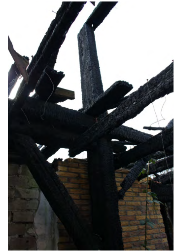
Foto 20: Restanten van de kapconstructie
