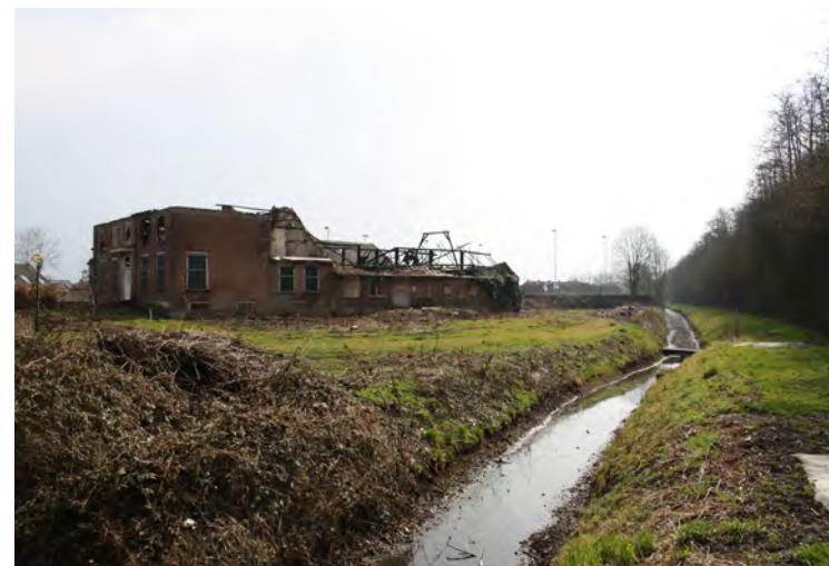
Foto 32: Sloop perceelsgrens noordzijde
