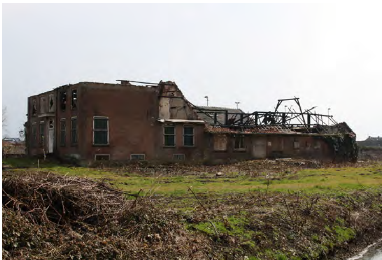
Foto 1: Overzicht westgevel boerderij
