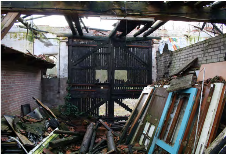
Foto 18: Deeldeuren vanaf binnenzijde deel gezien
