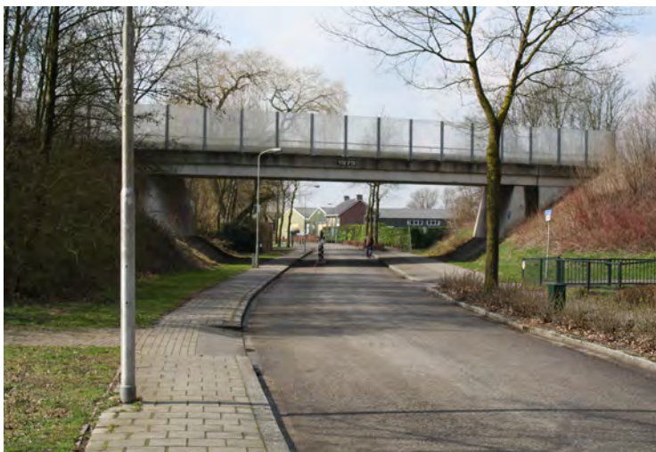
Foto 34: Naastgelegen viaduct en talud van de N233 (aanleg 1979)
