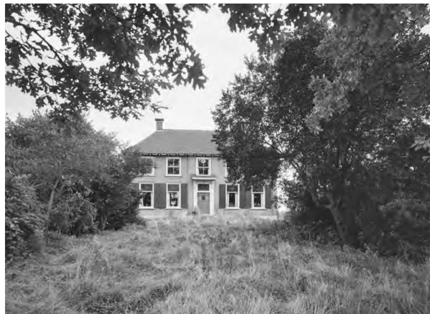
Boerderij 'Groenendaal', voorgevel 1972 (foto: Wal, A.J. van der, Beeldbank RCE).
