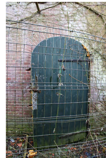
Foto 26: Zijdeur westgevel schuurwoning
