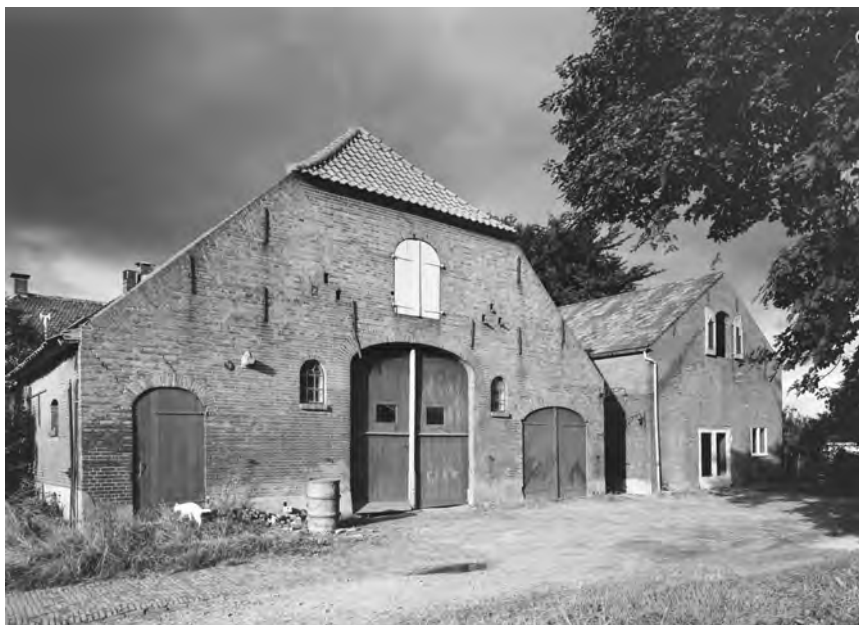
Boerderij 'Groenendaal', achtergevel 1972 (foto: Wal, A.J. van der, Beeldbank RCE).
