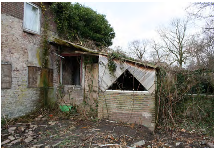
Foto 25: Oostgevel schuurwoning vanuit het zuiden gezien met aanbouw.
