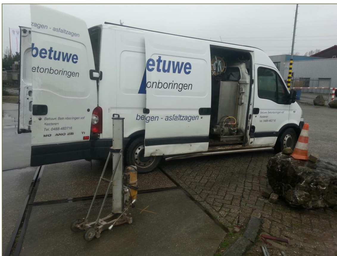
Figuur 11: Voorboren van de gaten met een betonboor
