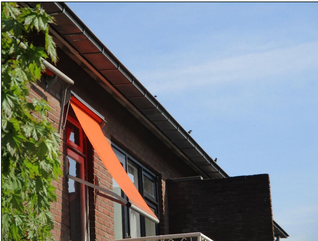
Figuur 3 Het dak van de Hoofdstraat 6-10 biedt minimaal 6 nestlocaties voor huismussen. Er zijn minimaal 4 nestlocaties aan de achterzijde aanwezig en minimaal 2 nestlocaties aan de voorzijde. Deze nestlocaties blijven behouden in de beoogde ontwikkeling.
