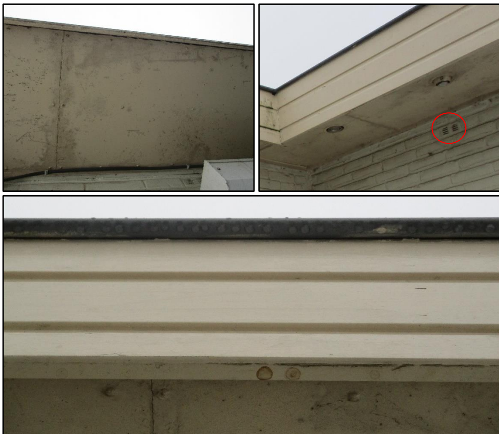
Figuur 4 In de woning zijn geen openingen aanwezig via welke vleermuizen toegang kunnen krijgen tot de spouw. Dakranden sluiten nauw aan; er zijn geen kieren tussen gevels en dakoverstek; en er zijn ventilatieroosters in plaats van open stootvoegen.
