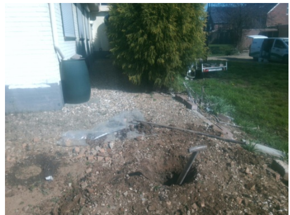
Foto 2: Asbestinspectiegat ter plaatse van de verhoging
