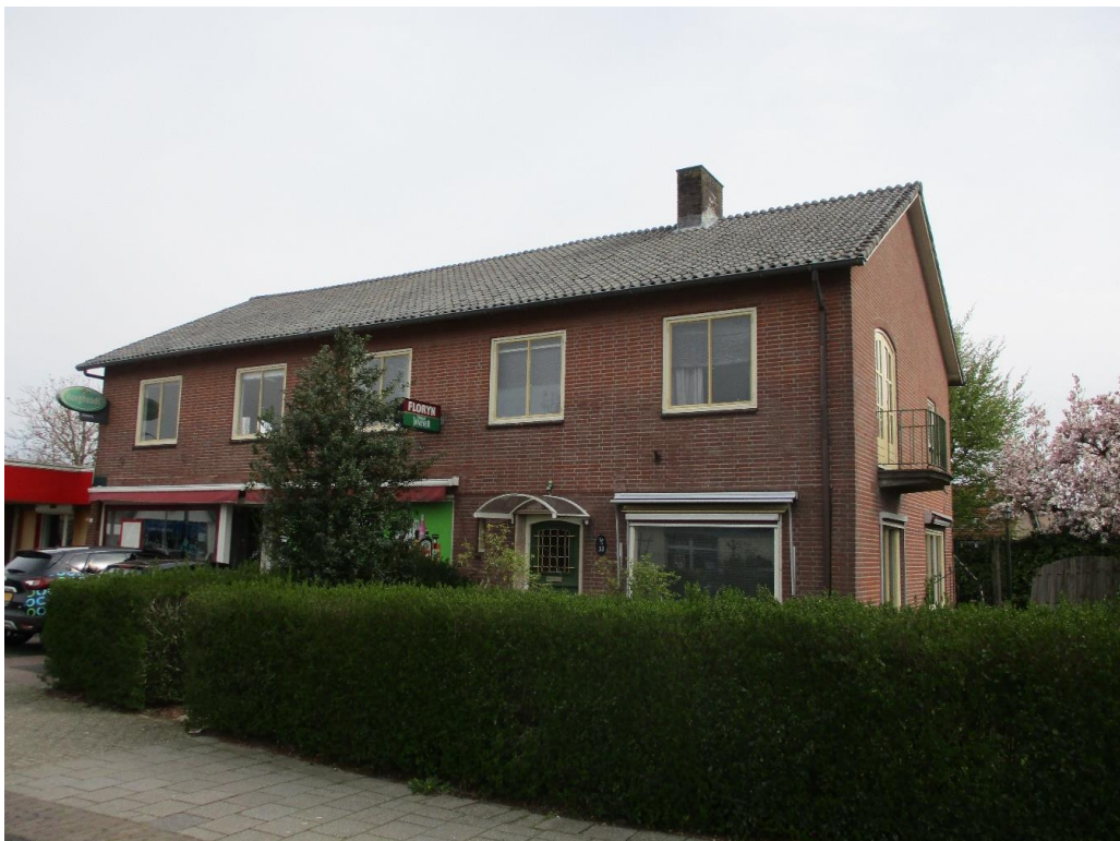
Figuur 2 Vooraanzicht van de twee-onder-een-kap woning. De woning bestaat uit drie bouwlagen en is opgetrokken uit gemetselde muren met spouw en zadeldak met dakpannen.
