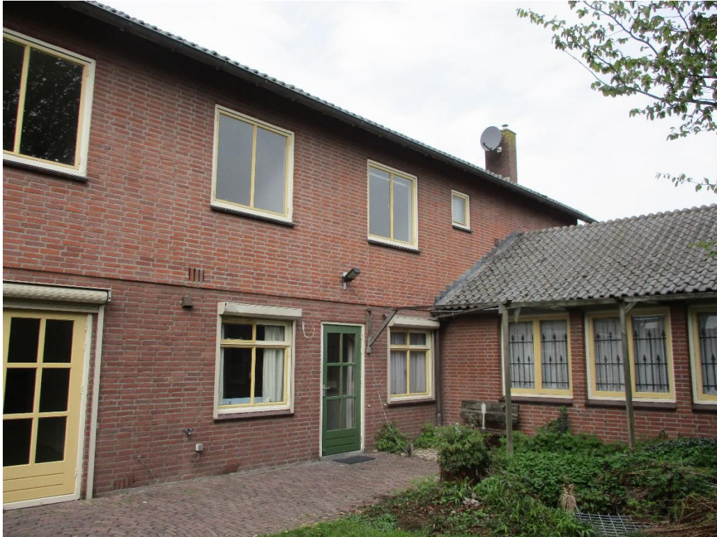
Figuur 3 Achterzijde van de woning. Tegen de woning is een schuur aangebouwd.
